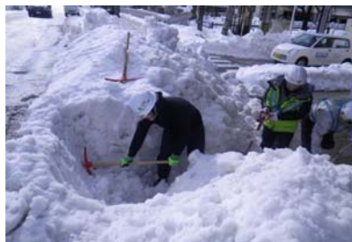
歩道の啓開除雪支援
