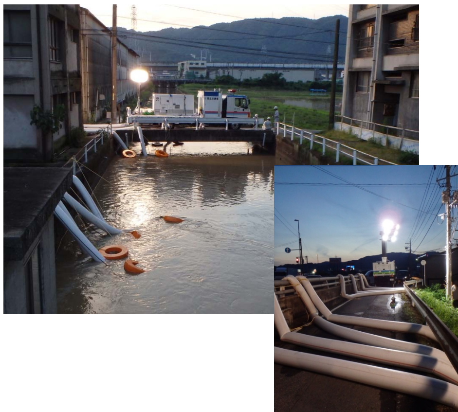
排水ポンプ車及び照明車活動状況:福山市神島町
