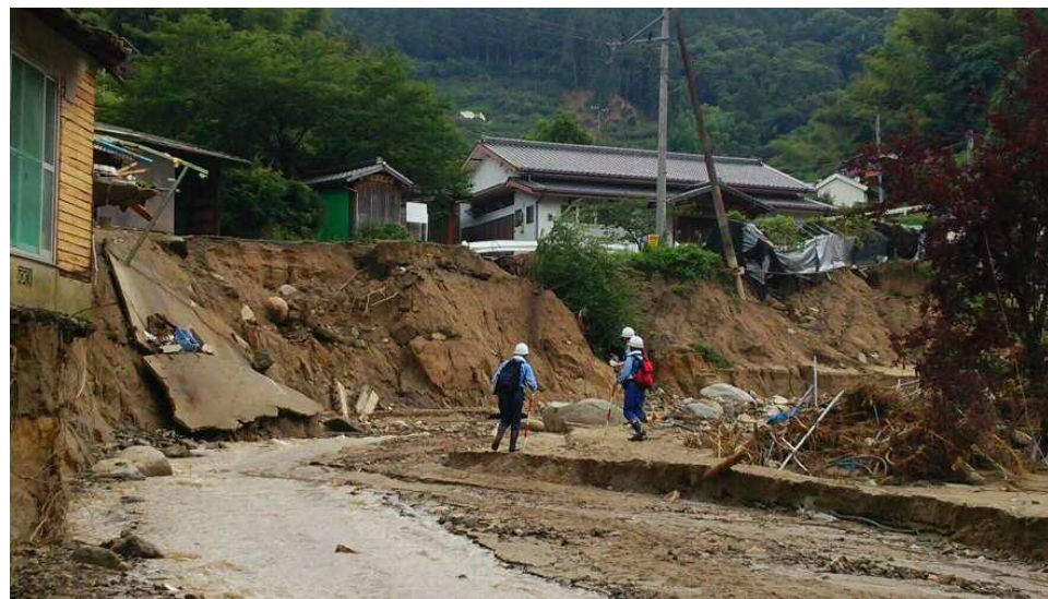
県道588号 道路啓開 調査状況
