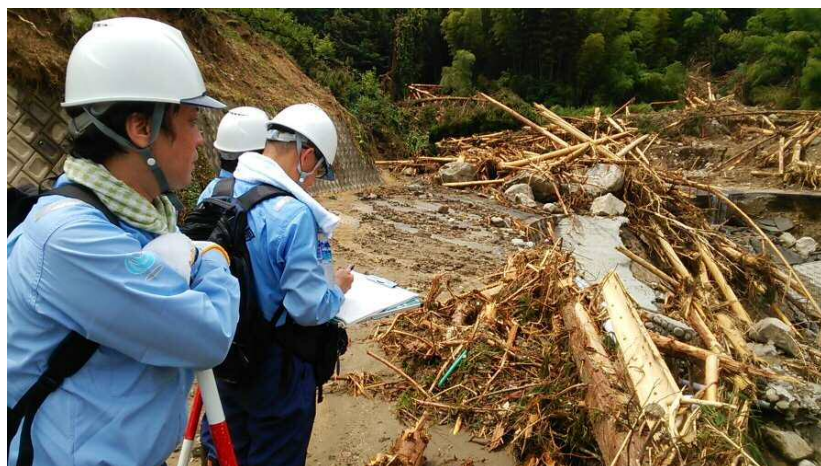
県道588号 道路啓開 調査状況
