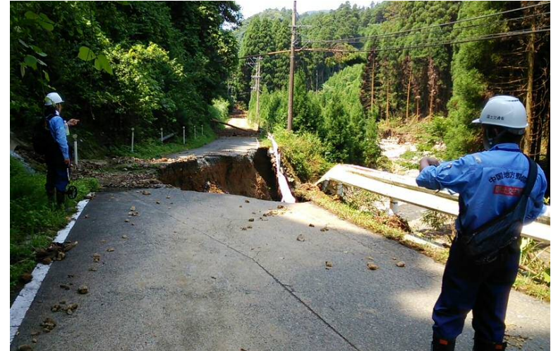
県道79号 道路啓開 調査状況
