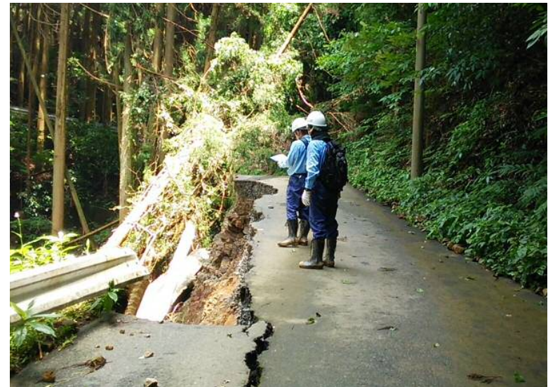
県道79号 道路啓開 調査状況
