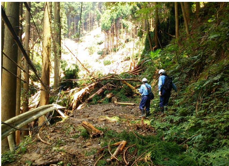
県道79号 道路啓開 調査状況
