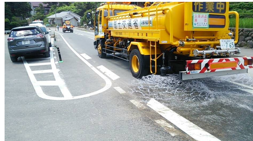
散水車 現地作業状況(東峰村:県道52号)
