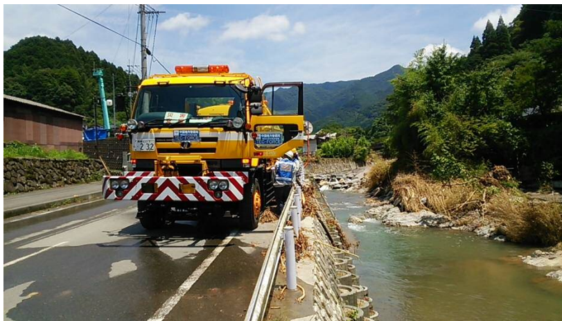
散水車 現地作業状況(東峰村:県道52号)
