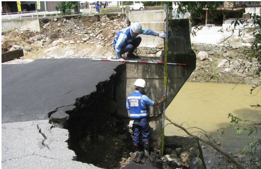
【被災状況調査班】夜明橋の橋台の被災状況調査
