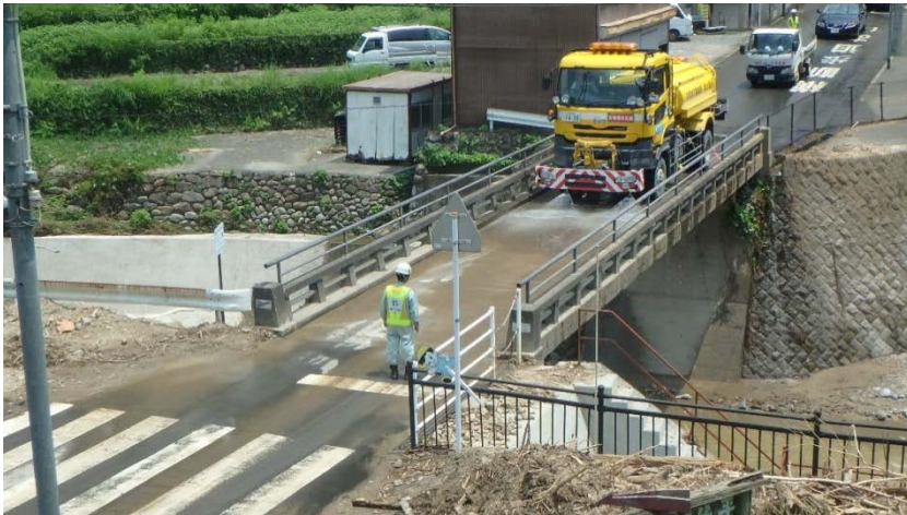
【応急対策班】日田市 村道散水状況
