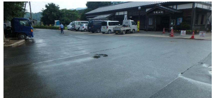
【応急対策班】東峰村 宝珠山駅 駐車場散水状況 (九州で唯一ホームが県境をまたぐ駅)
