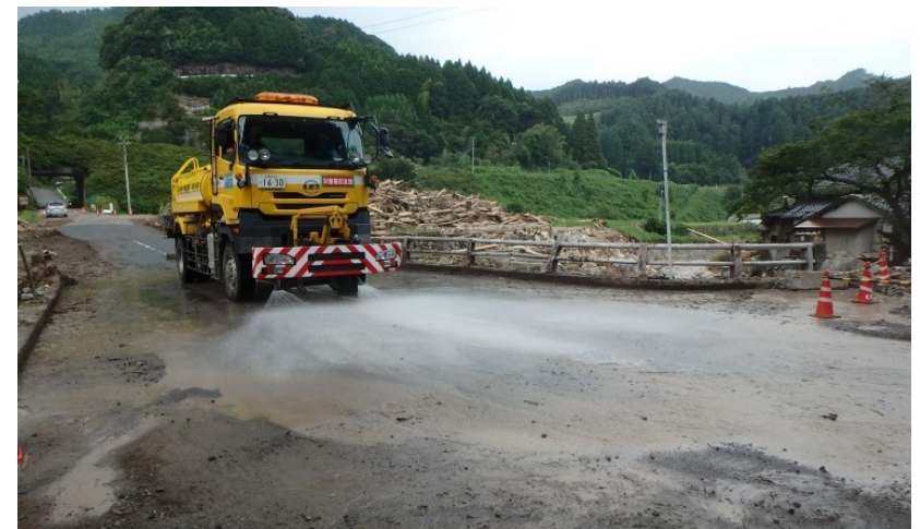
【応急対策班】日田市 県道52号 路面清掃状況
