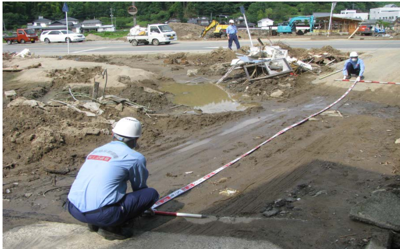
【道路②】日田市 市道調査状況 (大肥住宅線 被災調査)
