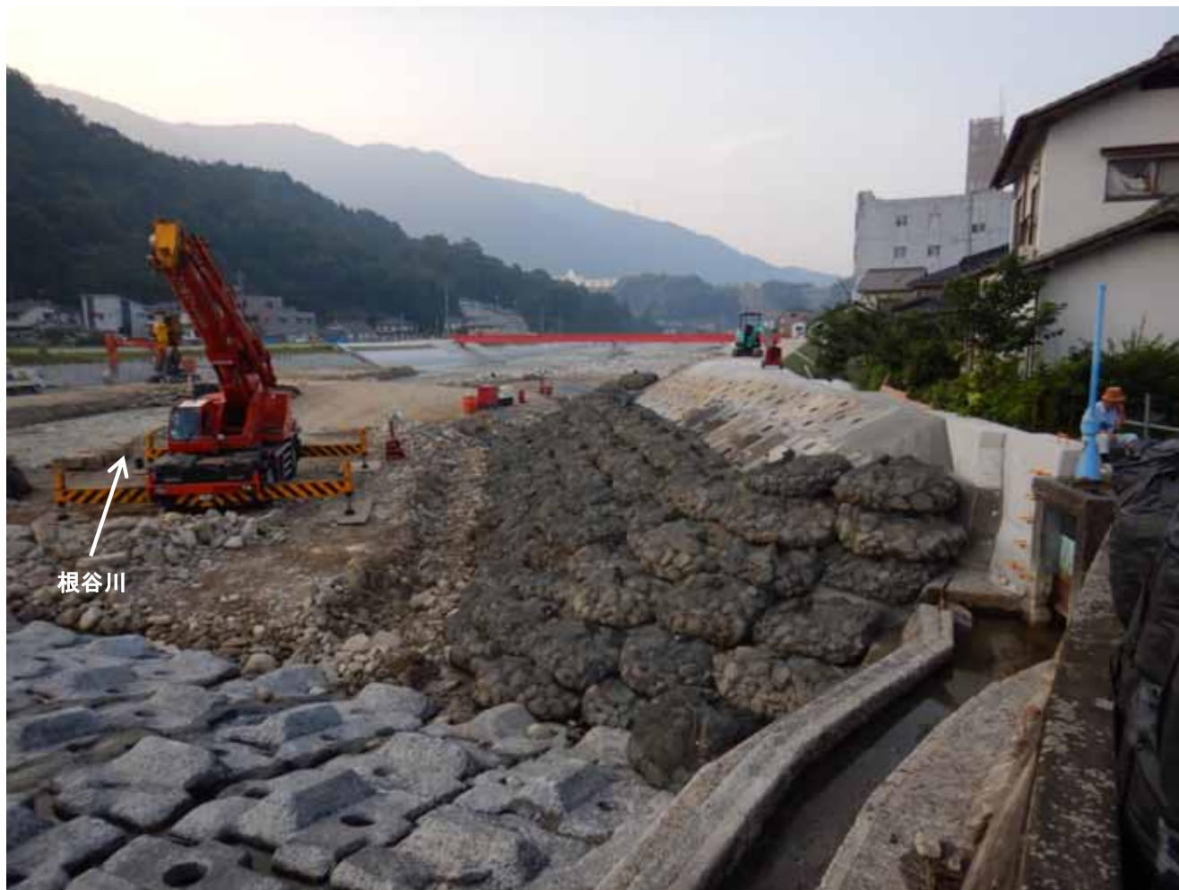
緊急対策工事完成状況(7月17日)
