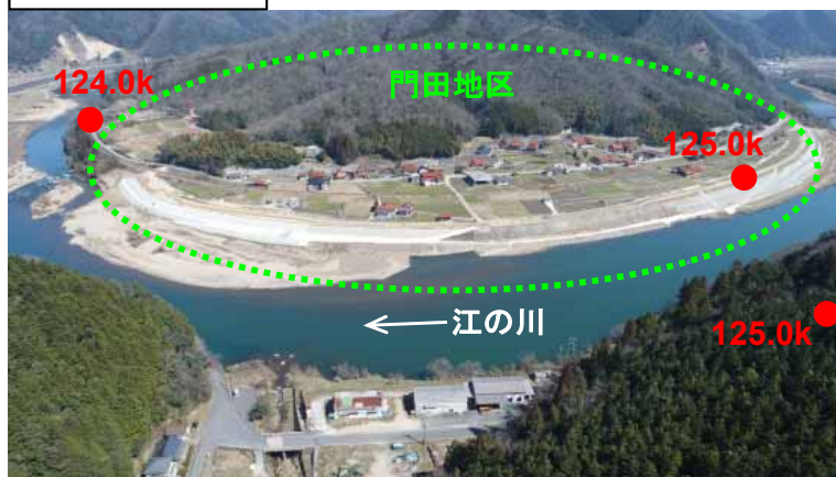
堤防整備状況
