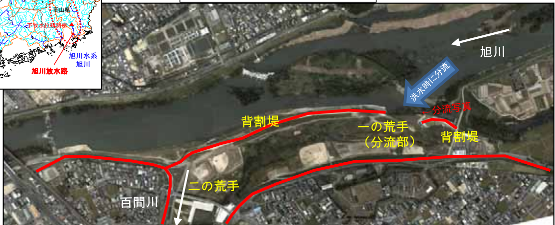
旭川放水路(百間川) 分流部
