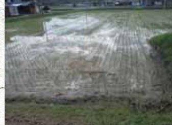
【基盤漏水】L=181m 吉井川右岸16k400付近
