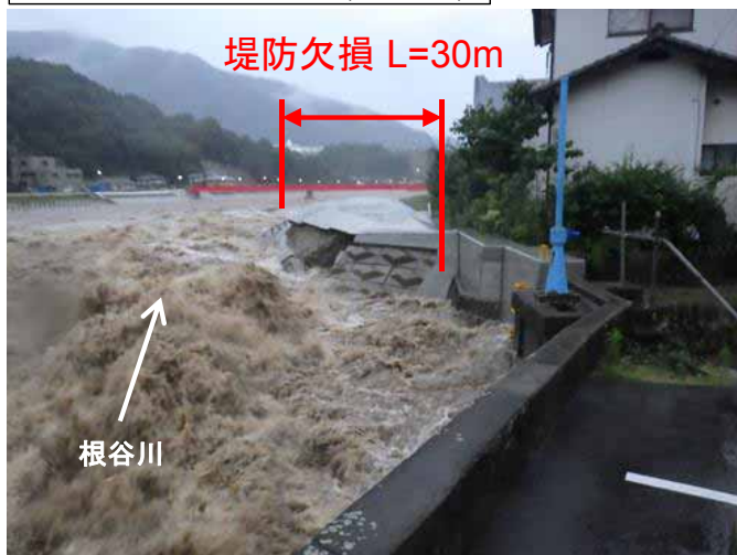
堤防の欠損状況(7月6日)
