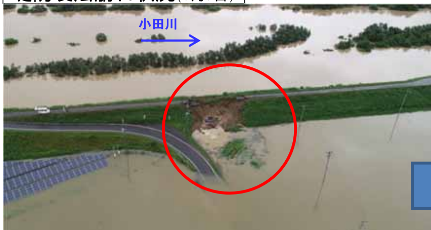
堤防裏法崩れ状況(7月7日)
