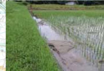
【基盤漏水】L=221m 吉井川右岸8k400付近
