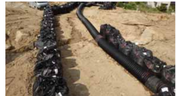
○流路工(大型土のう)設置
