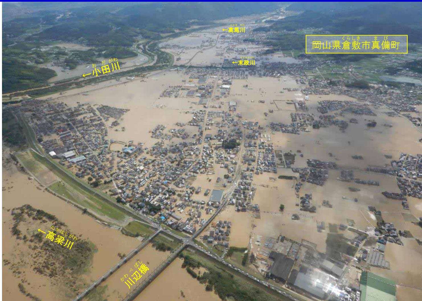
岡山県倉敷市真備町における浸水状況 (平成30年7月8日(日):国土交通省撮影)
