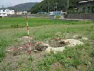
【基盤漏水】L=126m 吉井川右岸21k600付近
