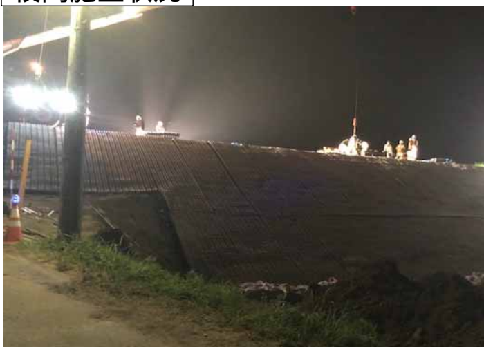
夜間施工状況
