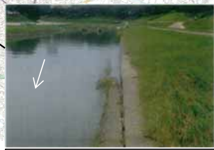
【護岸損壊】L=80m 旭川左岸8k600付近
