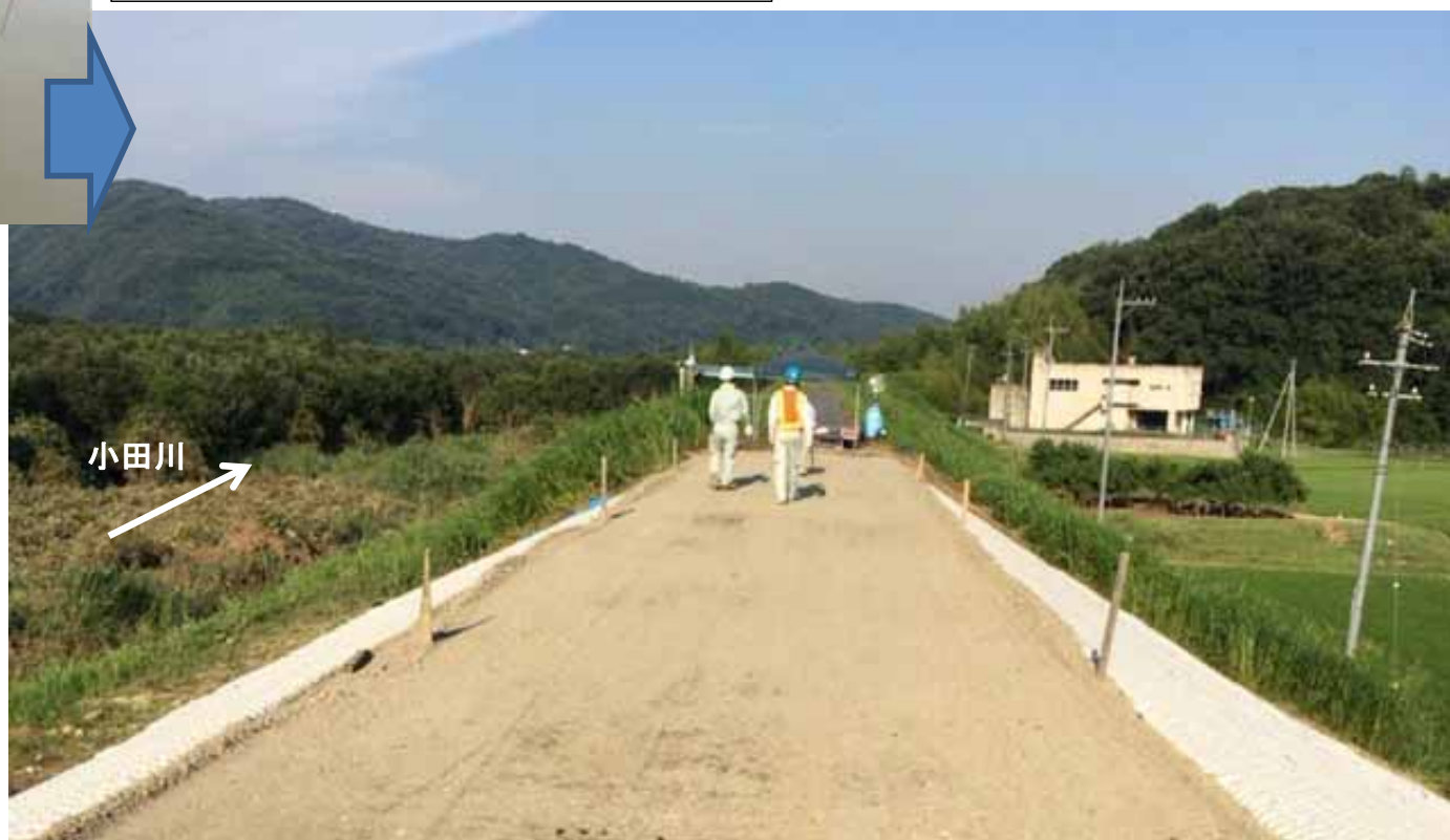
緊急対策工事完成状況(7月16日)
