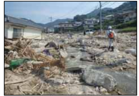
総頭川下流の河道を埋塞する大量の土砂
