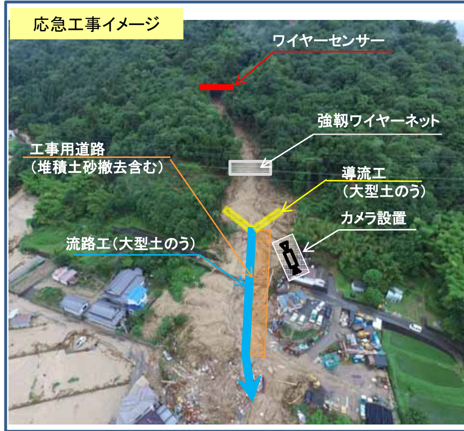
○土石流監視警報装置(ワイヤーセンサー)
