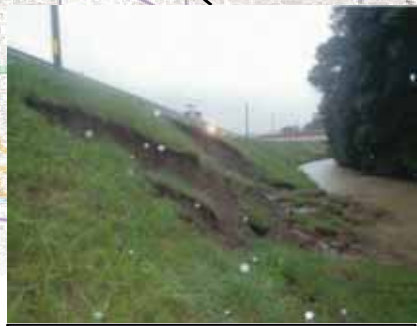
【裏法崩れ】L=30m 旭川右岸17k100付近
