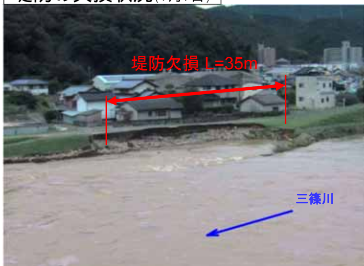
堤防の欠損状況(7月7日)
