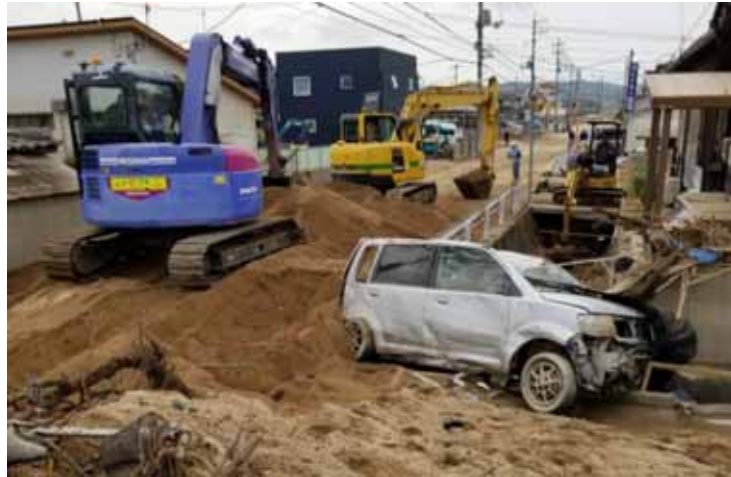
土砂撤去作業
