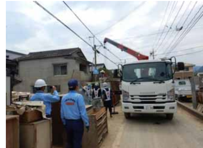
支障物撤去作業
