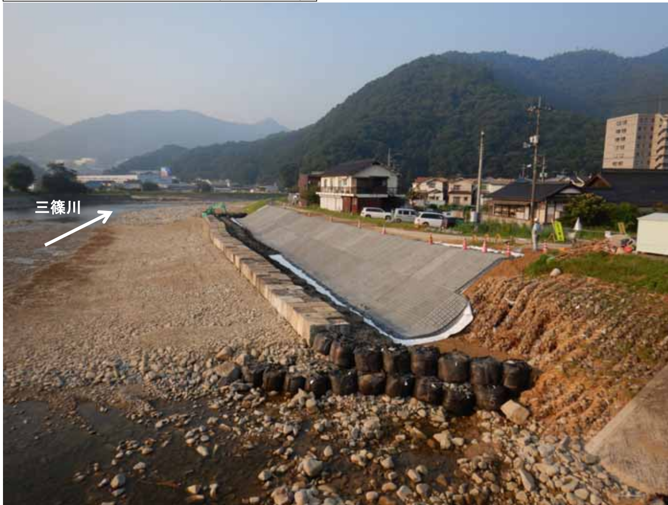
緊急対策工事完成状況(7月17日)
