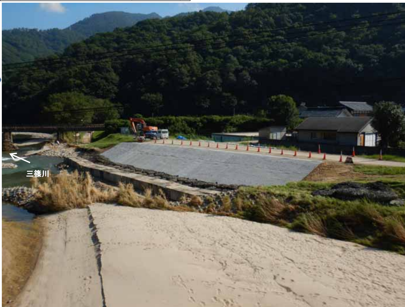
緊急対策工事完成状況(7月15日)
