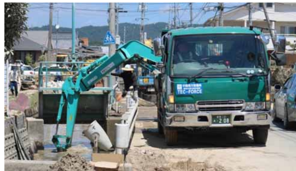
水路啓開作業
