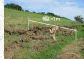
【裏法崩れ】L=210m 吉井川右岸13k200付近
