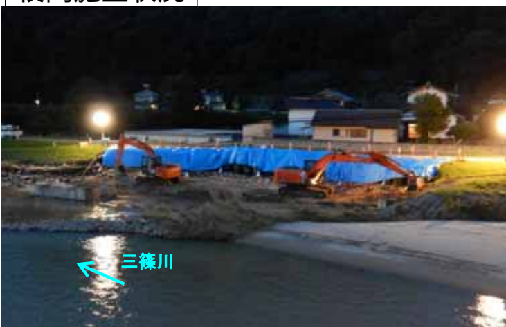
夜間施工状況
