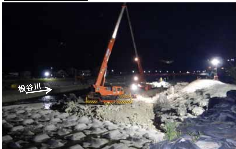
夜間施工状況
