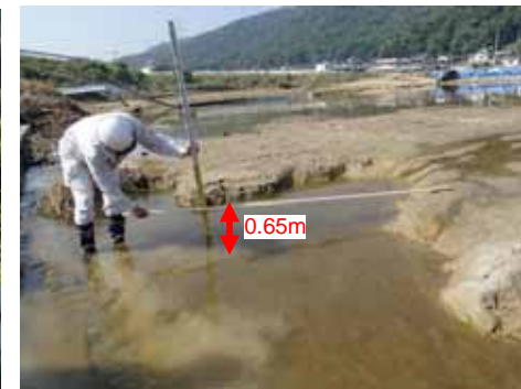
③左岸堤内側の洗掘状況 7月15日撮影
