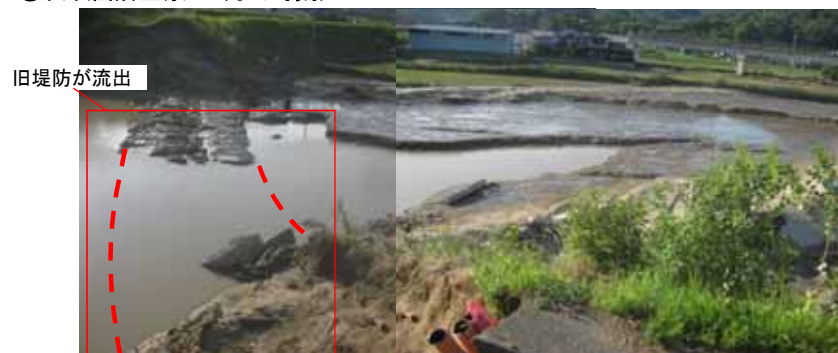
③決壊箇所堤内側の落堀状況 7月9日撮影
