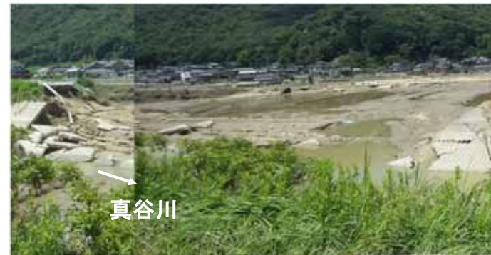
①決壊箇所全景 7月10日撮影
