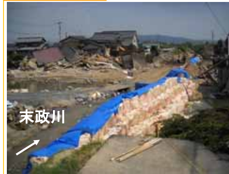
①決壊箇所全景 7月15日撮影
