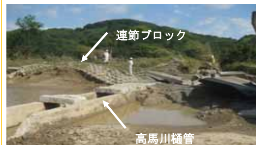
③ 高馬川樋管破損状況 7月9日撮影
