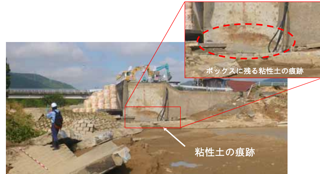
高馬川橋周辺の土砂状況
