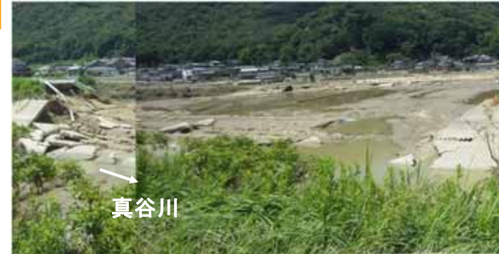
①決壊箇所全景 7月10日撮影
