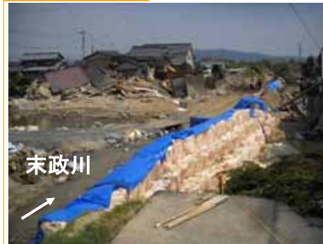
①決壊箇所全景 7月15日撮影
