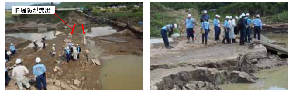
④決壊箇所の堤防構築跡 7月10日撮影
