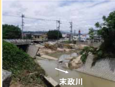
①決壊箇所全景 7月9日撮影
