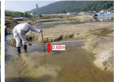
③左岸堤内側の洗掘状況 7月15日撮影
