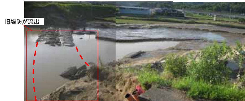
③決壊箇所堤内側の落堀状況 7月9日撮影
