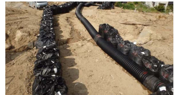
○流路工(大型土のう)設置
