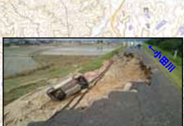
【裏法崩れ】L=約80m 小田川左岸4k200付近
