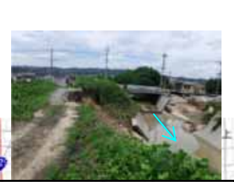
【堤防の決壊】L=約20m 末政川左岸0k400付近(県)
