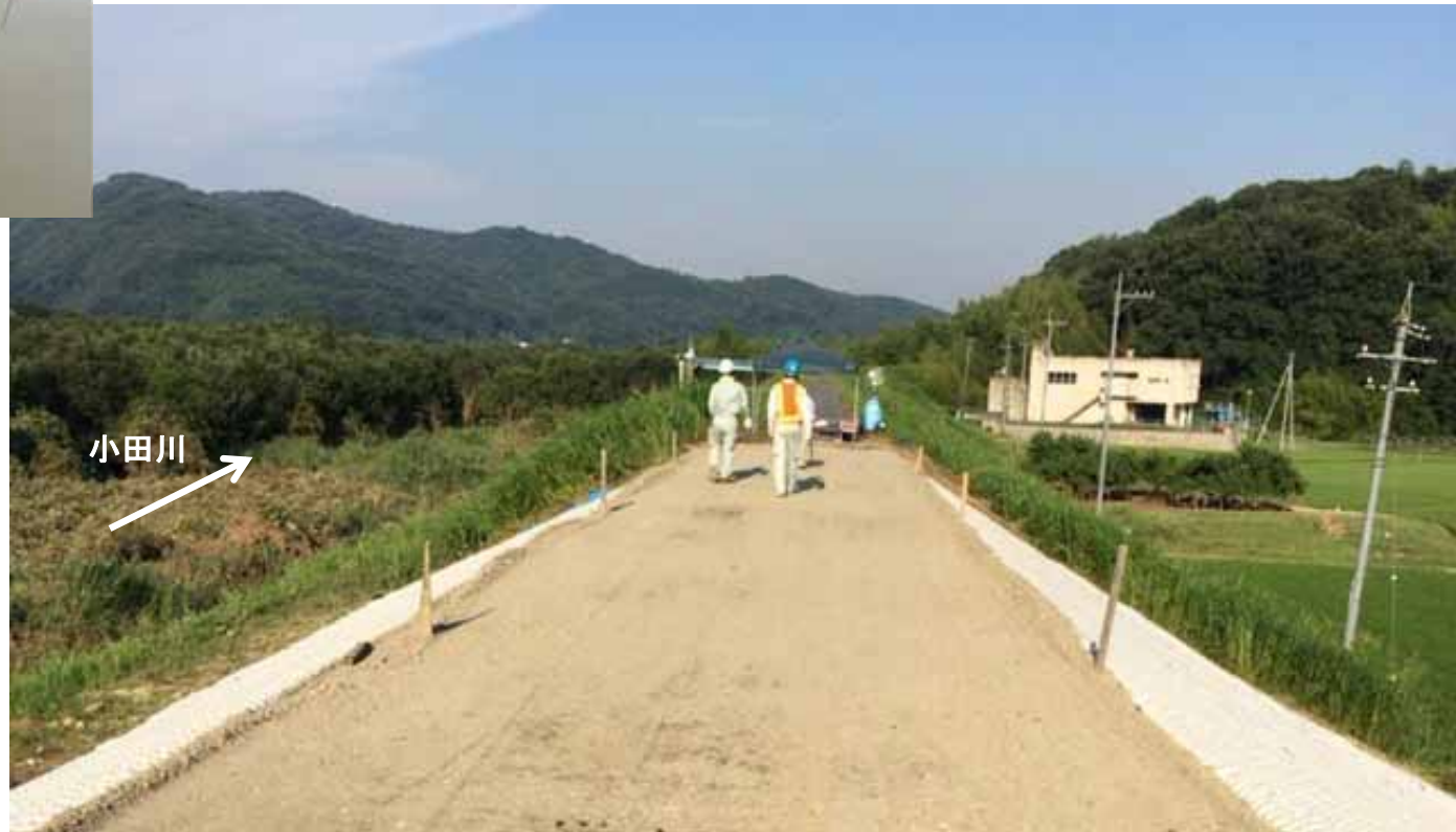
緊急対策工事完成状況(7月16日)
