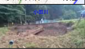
【裏法崩れ】L=約16m 小田川右岸4k200付近
