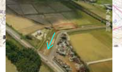
【裏法崩れ】L=約50m 大武谷川(県)小田川合流点付近
