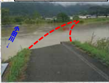
【堤防の決壊】L=約50m 小田川左岸6k400付近
