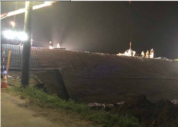
夜間施工状況
