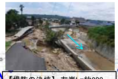
【堤防の決壊】左岸L=約200m 右岸L=約300m 末政川左右岸0k700付近(県)
