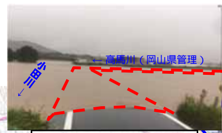
【堤防の決壊】L=約100m 小田川左岸3k400付近
