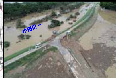
【裏法崩れ】L=約1,000m(点在) 小田川右岸2k800~3k800付近
