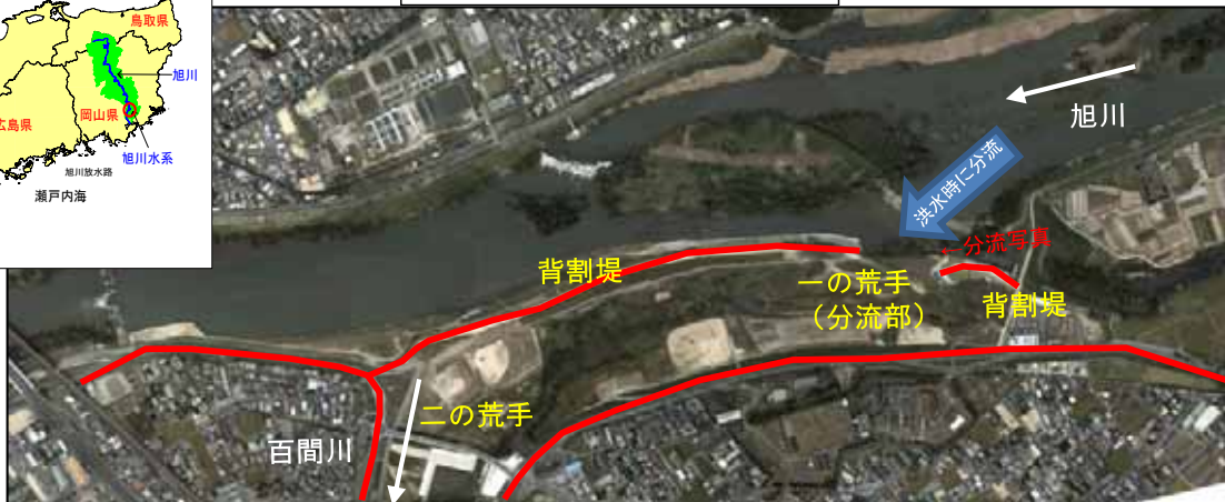
旭川放水路(百間川) 分流部
