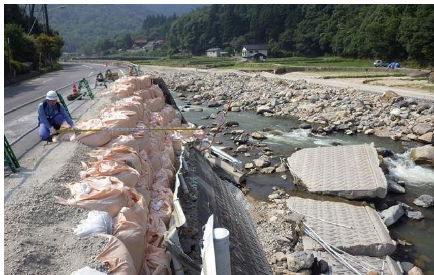
被災状況調査(広島市)
