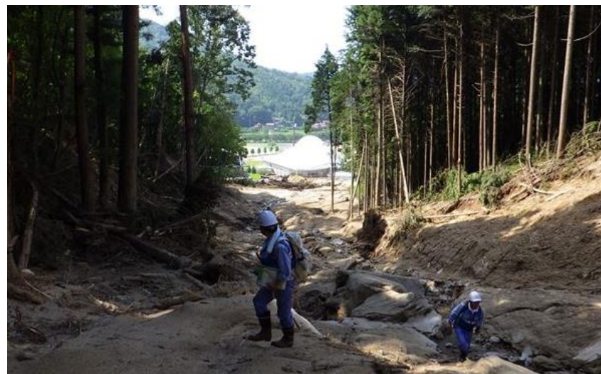
被災状況調査(三原市)
