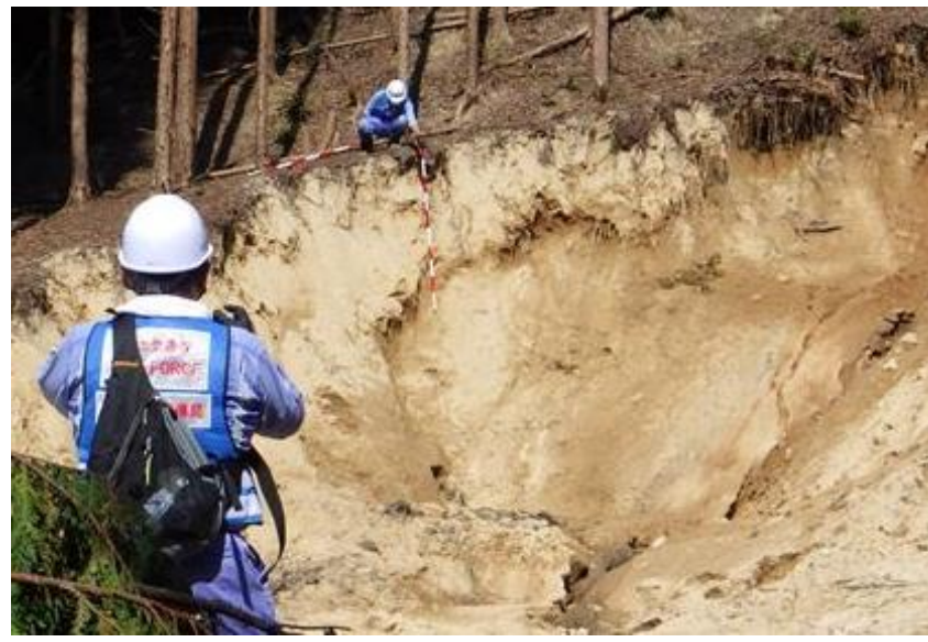
被災状況調査(三原市)
