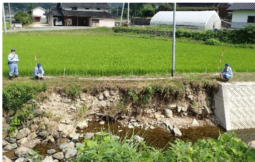
被災状況調査(新見市)
