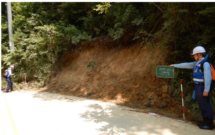
被災状況調査(熊野町)
