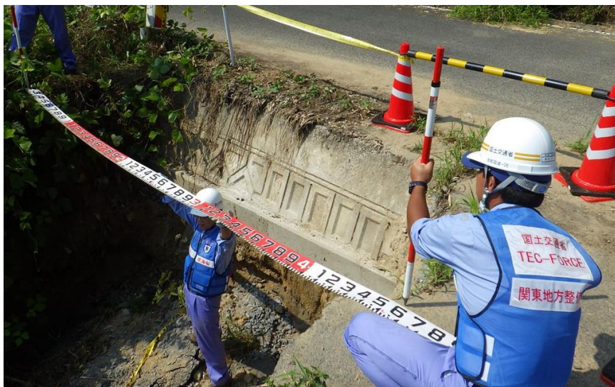
被災状況調査(東広島市)
