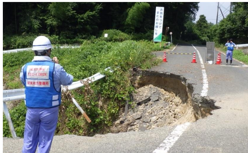
被災状況調査(東広島市)
