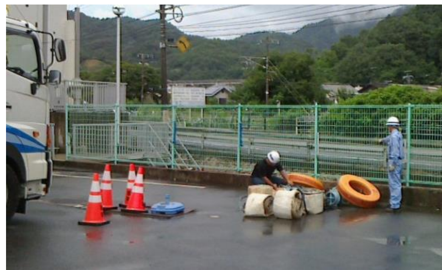
排水ポンプ車準備状況（坂町）
