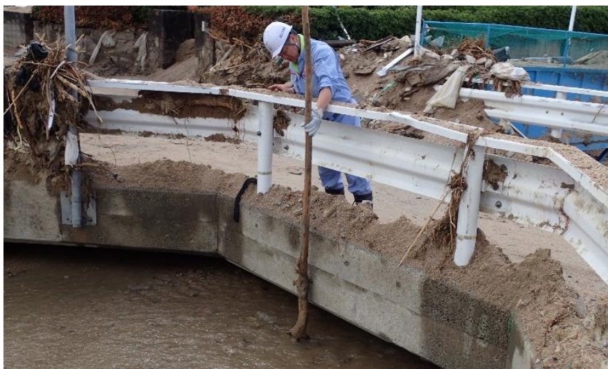
現地状況確認（坂町：総頭川）
