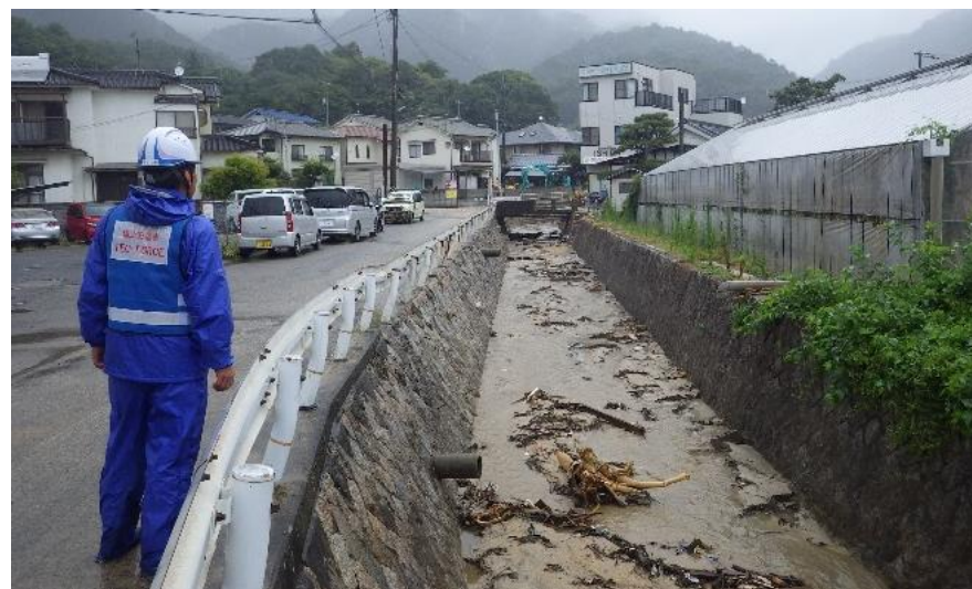
現地状況確認（呉市：背戸川）
