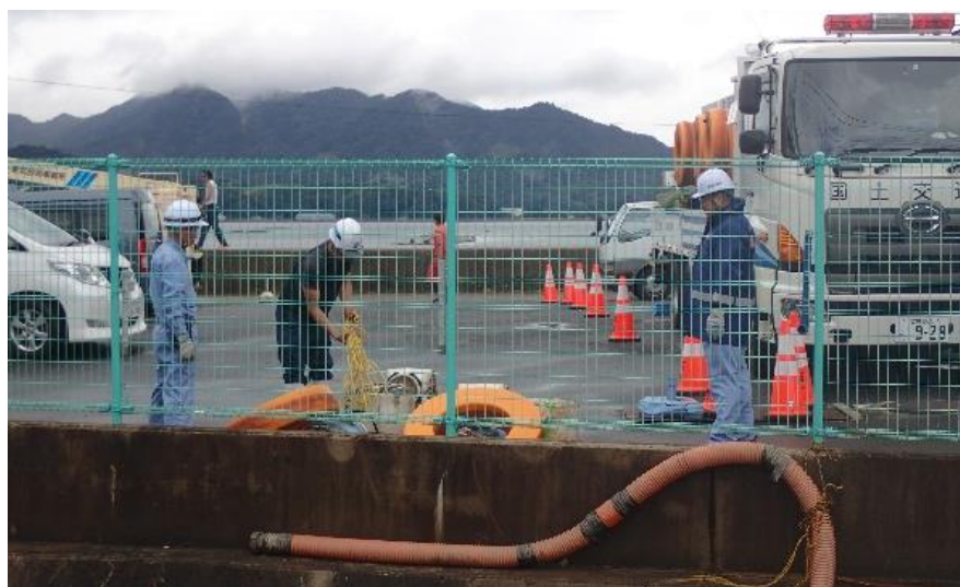
排水ポンプ車準備状況（坂町）
