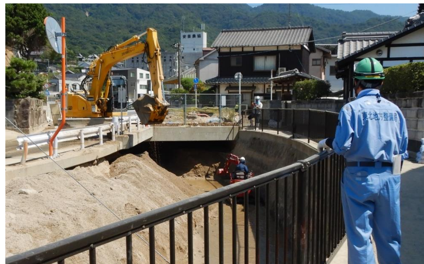
現地状況確認（坂町坂西）
