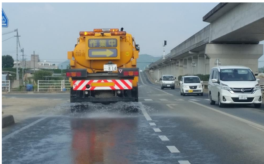
清掃作業（倉敷市真備町）
