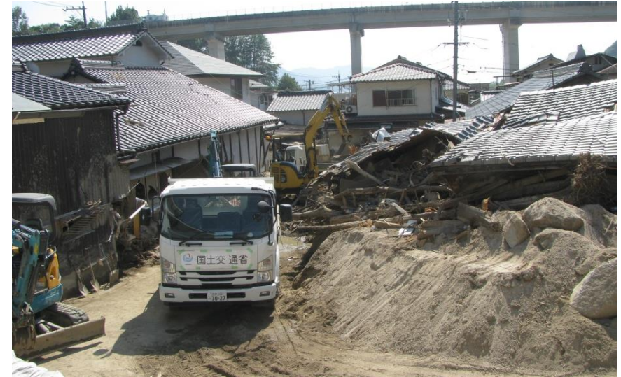
道路啓開作業（坂町小屋浦）
