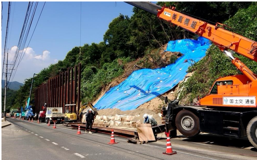
土工用防護柵設置支援（尾道市美ノ郷町）
