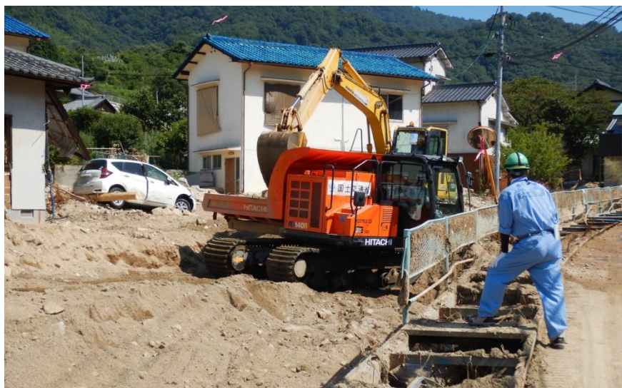
現地状況確認（坂町坂西）
