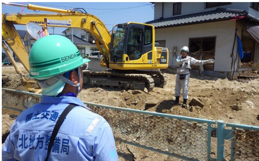
現地状況確認（坂町坂西）
