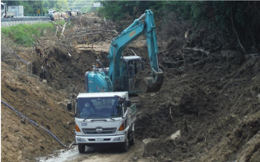
土砂撤去作業（東広島市高屋町）
