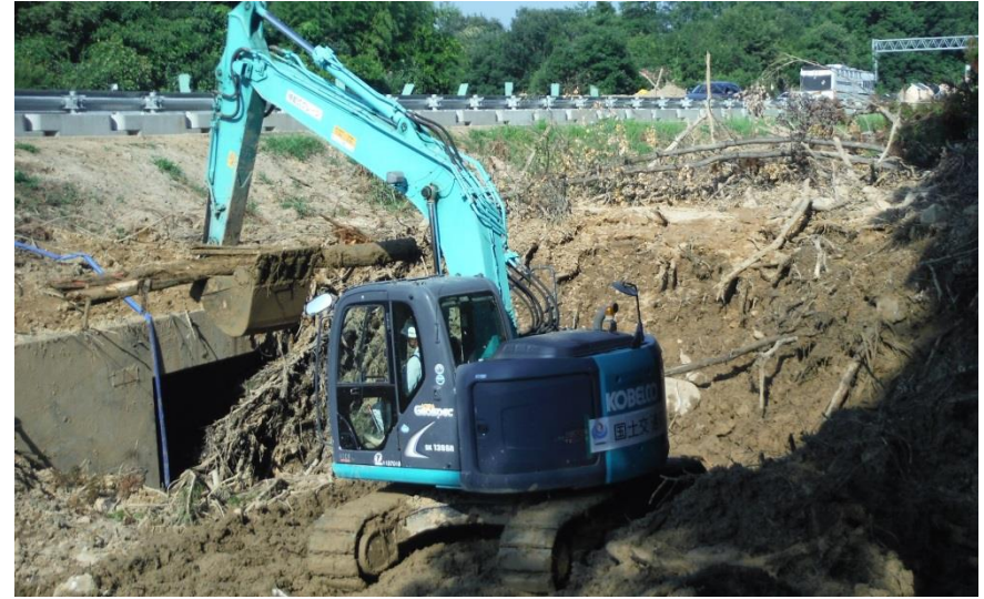
土砂撤去作業（東広島市高屋町）
