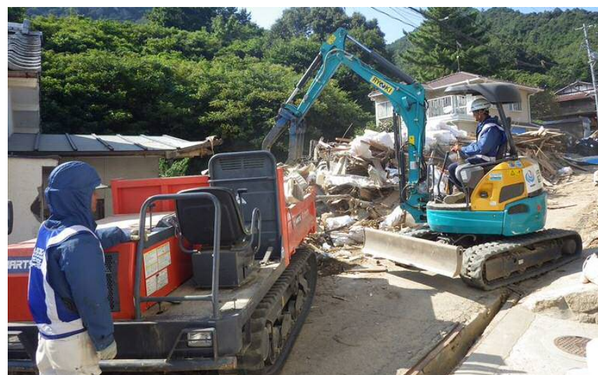
道路啓開作業（呉市天応町）
