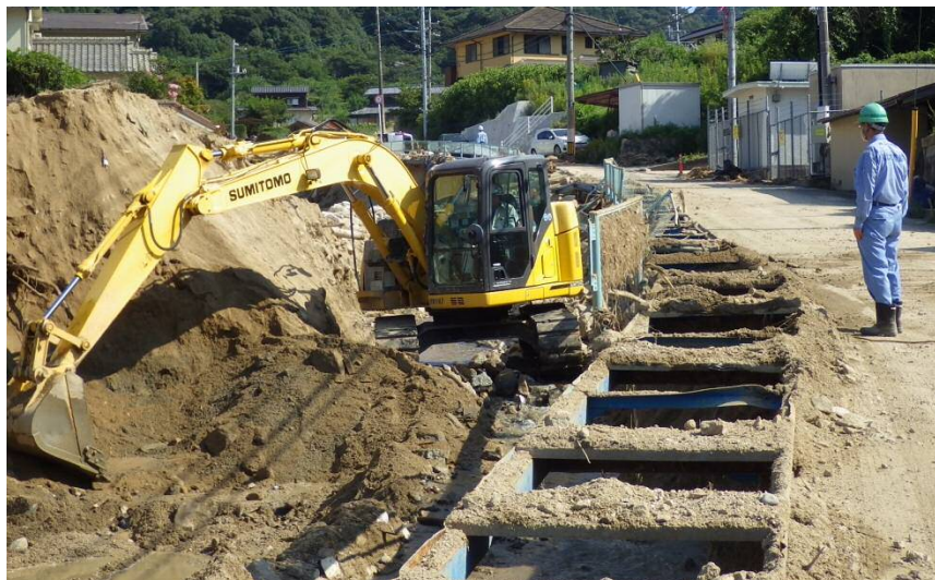
現地状況確認（坂町坂西）
