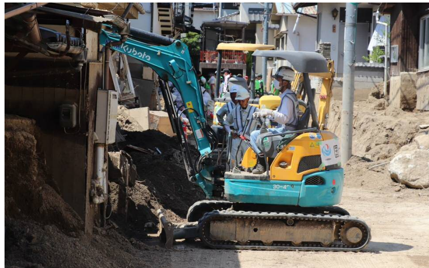
土砂撤去作業（坂町小屋浦）
