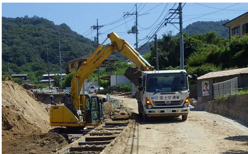
土砂撤去作業（坂町坂西）
