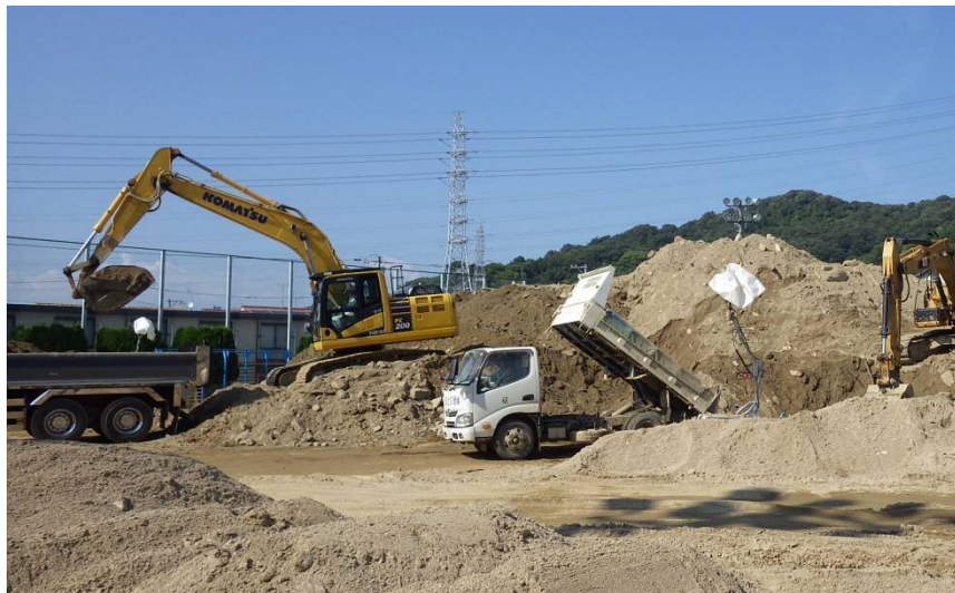
土砂撤去作業（坂町坂西）
