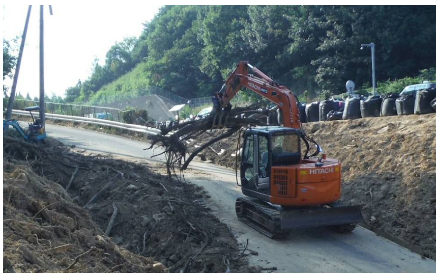
道路啓開作業（東広島市高屋町※H30.7.4）
