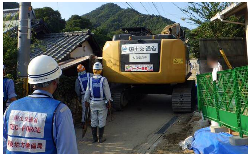
重機搬入確認（呉市天応町）
