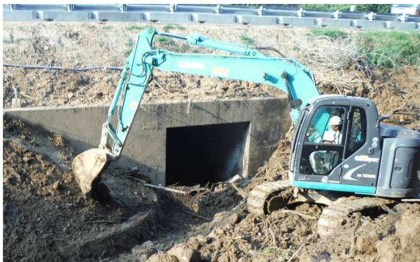
道路啓開作業（東広島市高屋町※H30.7.4）
