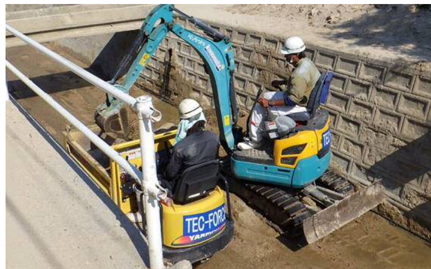
土砂撤去作業（呉市天応町）
