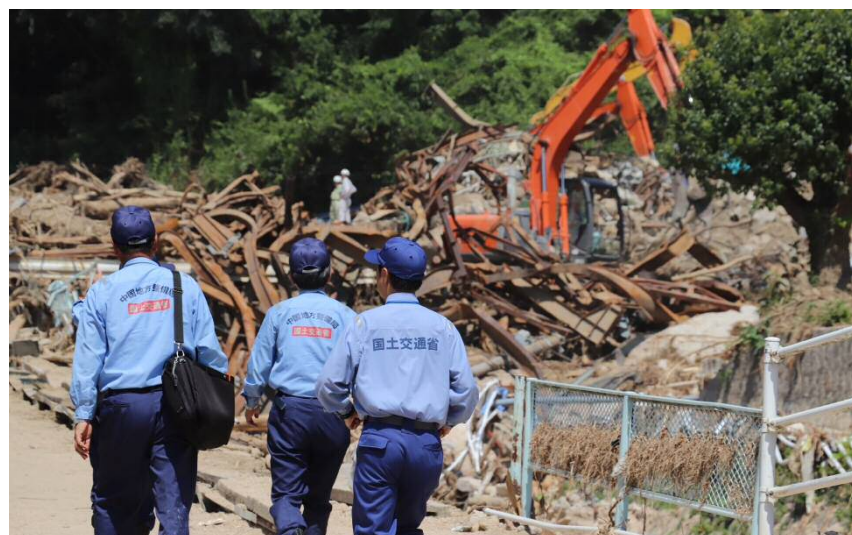
現地状況確認（坂町小屋浦）
