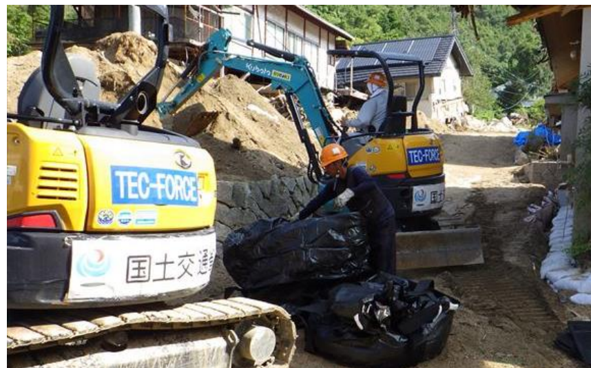
道路啓開作業（呉市天応町）
