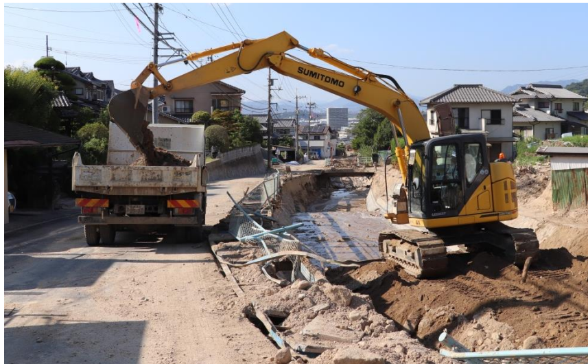
土砂撤去作業（坂町坂西）
