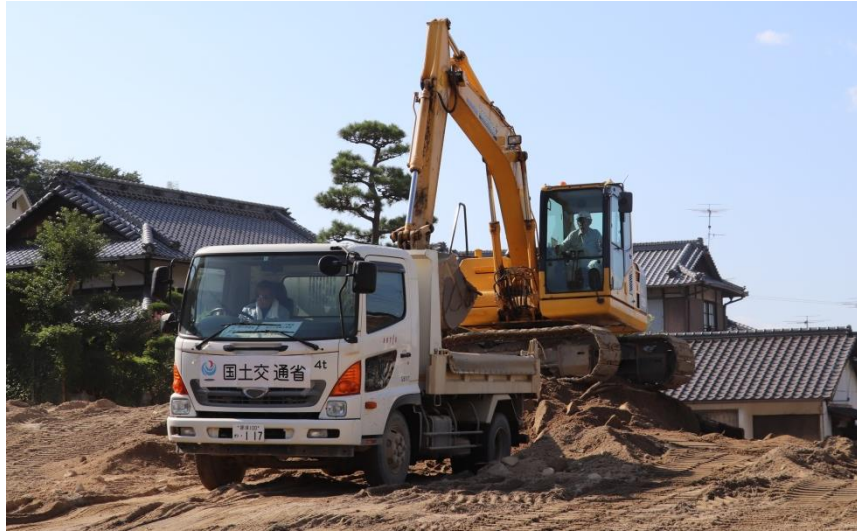
土砂撤去作業（坂町坂西）
