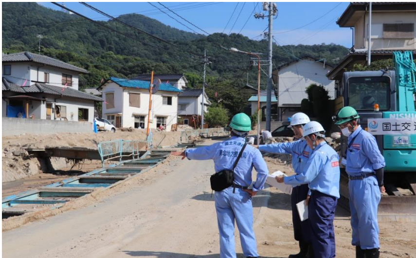
中国地整幹部現地視察（坂町坂西）
