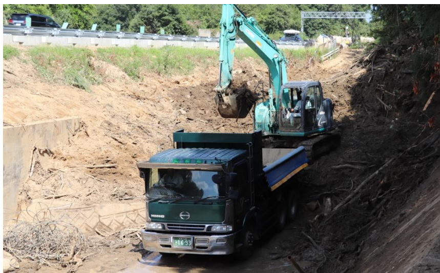
道路啓開作業（東広島市高屋町）
