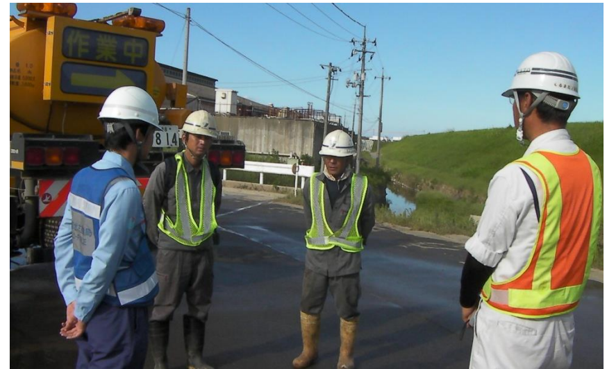
打合せ状況（倉敷市真備町）
