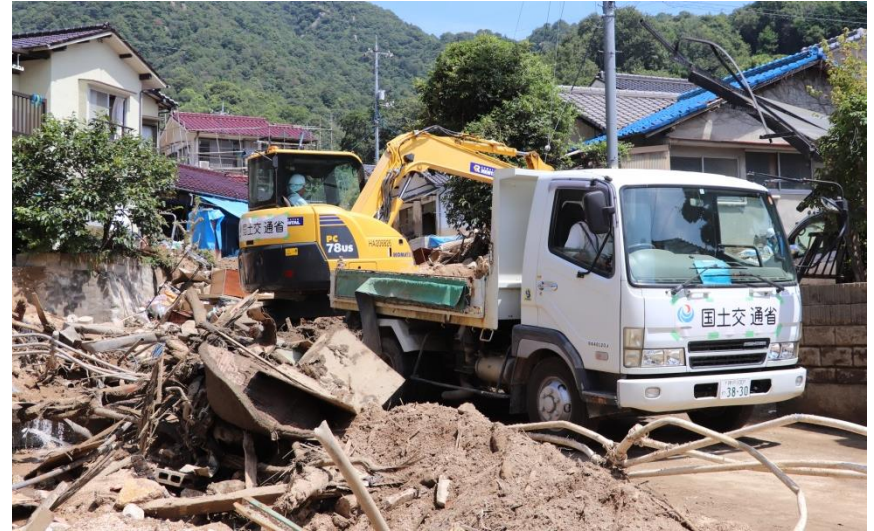
土砂撤去作業（坂町小屋浦）
