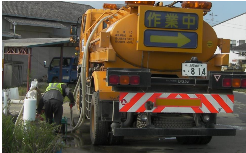
給水作業（倉敷市真備町）
