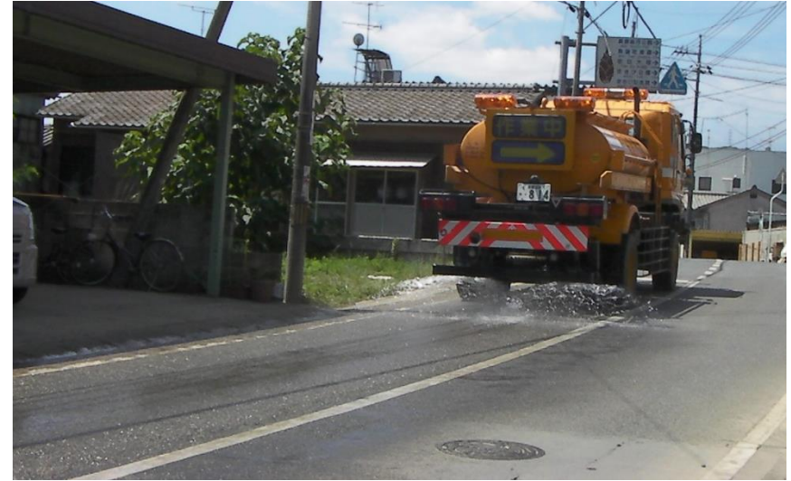
散水作業（倉敷市真備町）
