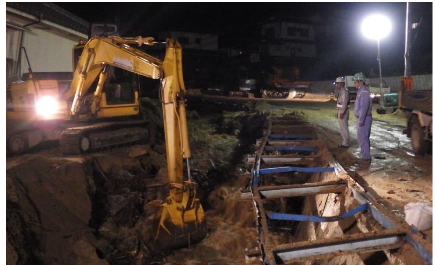
夜間状況確認（坂町坂西）
