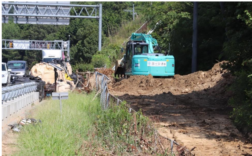
道路啓開作業（東広島市高屋町）
