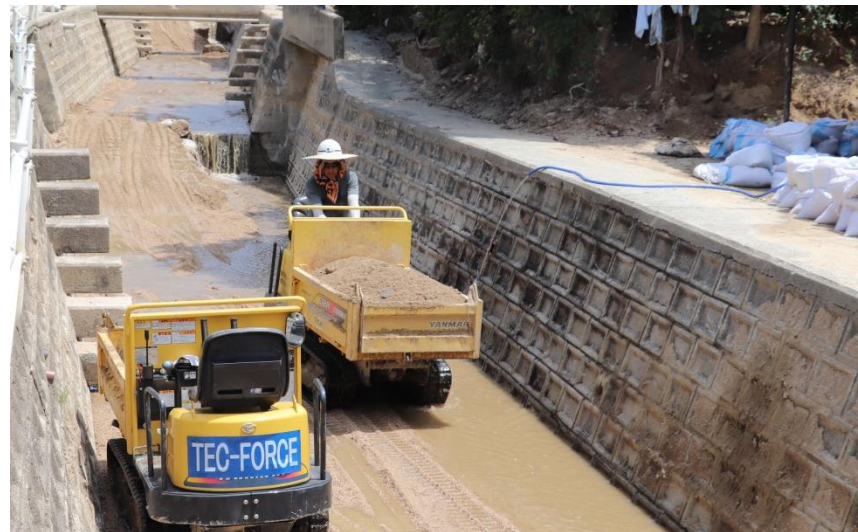
土砂撤去作業（呉市天応町）
