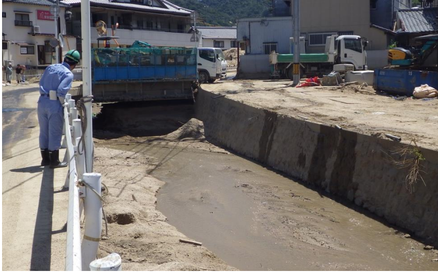
現地状況確認（坂町坂西）
