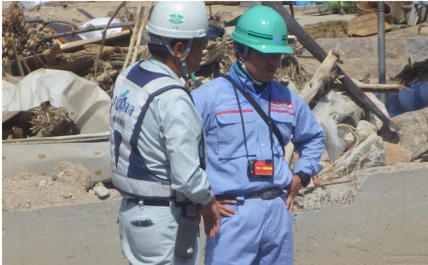
施工業者との現地確認（坂町坂西）
