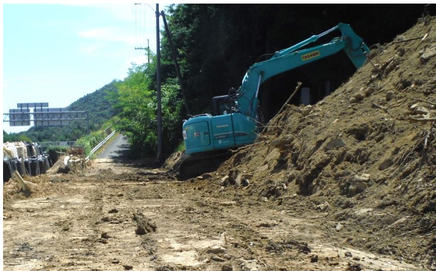
道路啓開作業（東広島市高屋町）
