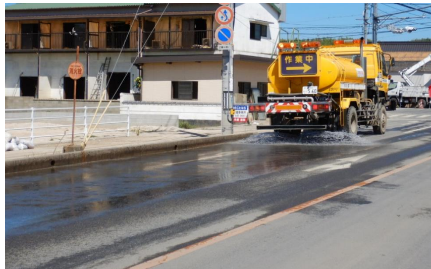
散水作業（倉敷市真備町）
