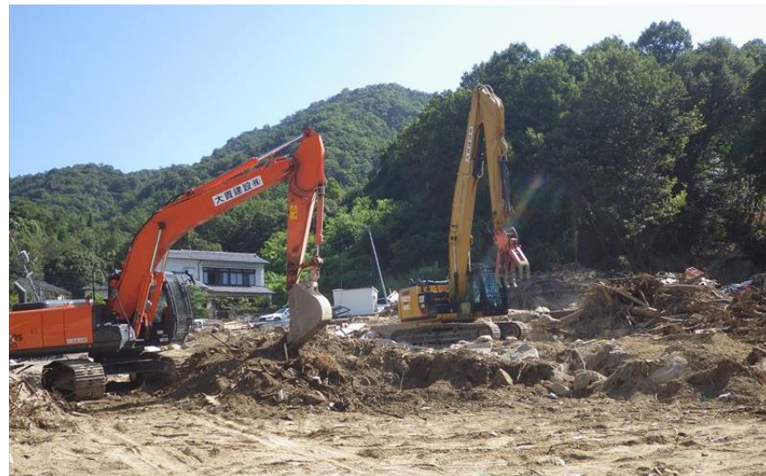
土砂撤去作業（呉市天応町）
