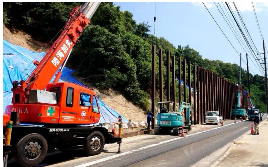
防護柵設置作業（尾道市美ノ郷町※H30.8.6）
