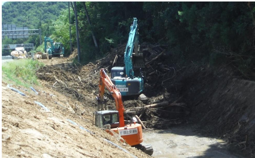
道路啓開作業（東広島市高屋町）
