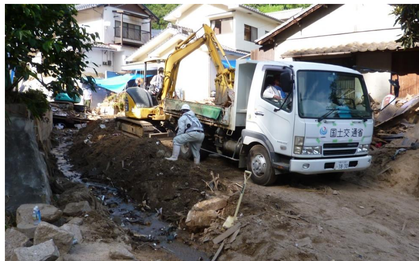
道路啓開作業（坂町小屋浦）
