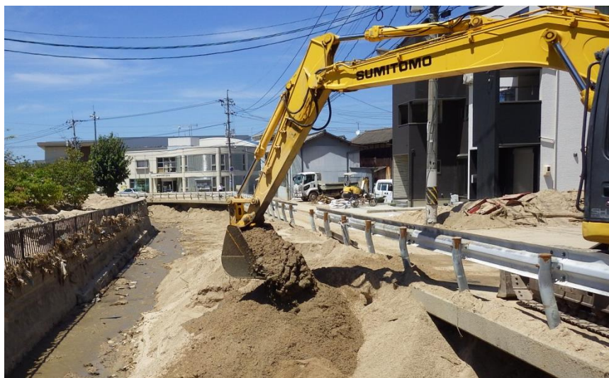
土砂撤去作業（坂町坂西）
