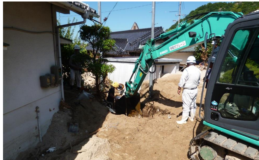
道路啓開作業（坂町小屋浦）
