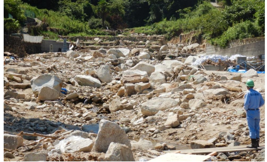
被災状況確認（坂町坂西）
