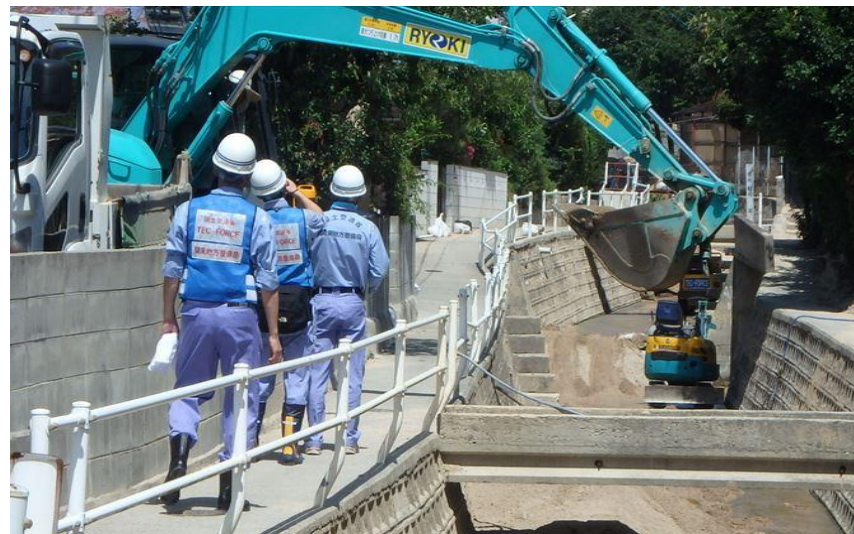
現地状況確認（呉市天応町）
