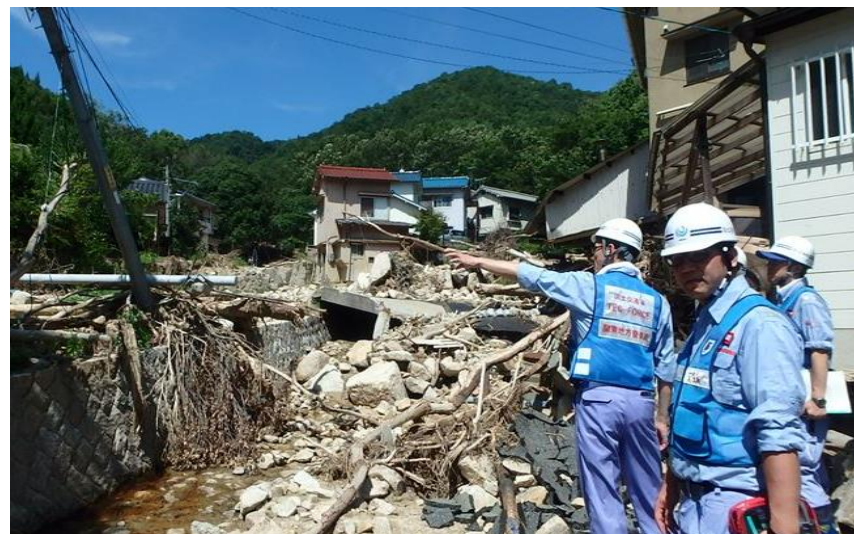
被災状況確認（呉市天応町）
