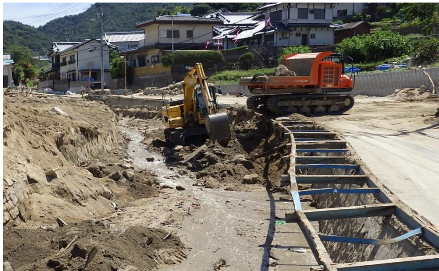
土砂撤去作業（坂町坂西）
