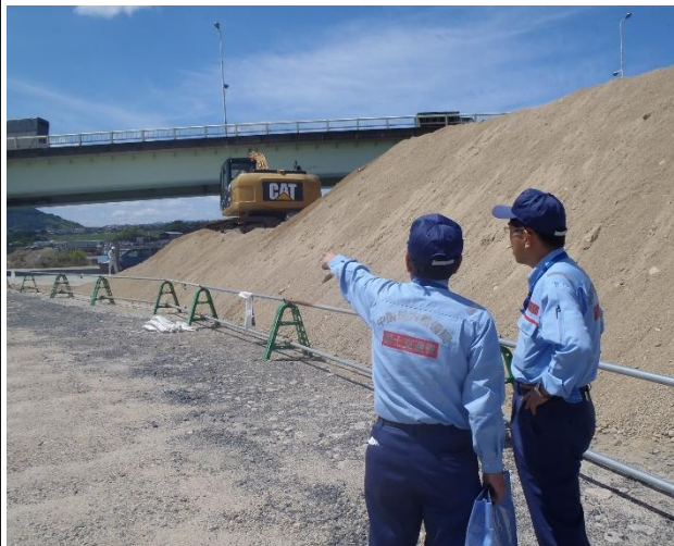
災害土砂の海上積出し拠点の確認 (広島港海田地区)
