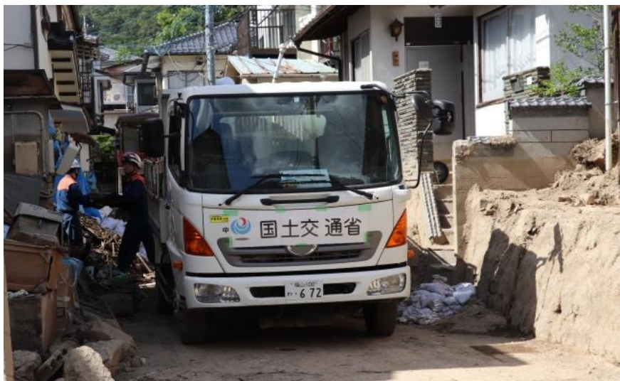
土砂撤去作業（坂町小屋浦）
