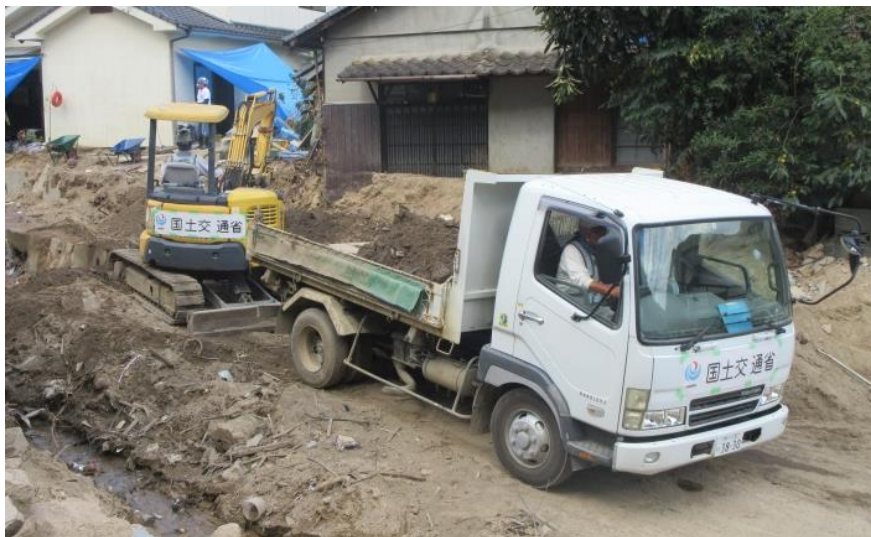
土砂撤去作業（坂町小屋浦）
