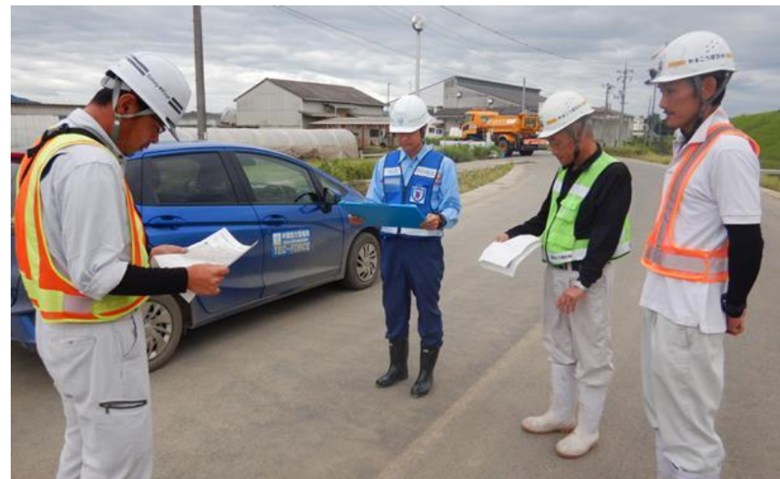
打合せ状況（倉敷市真備町）
