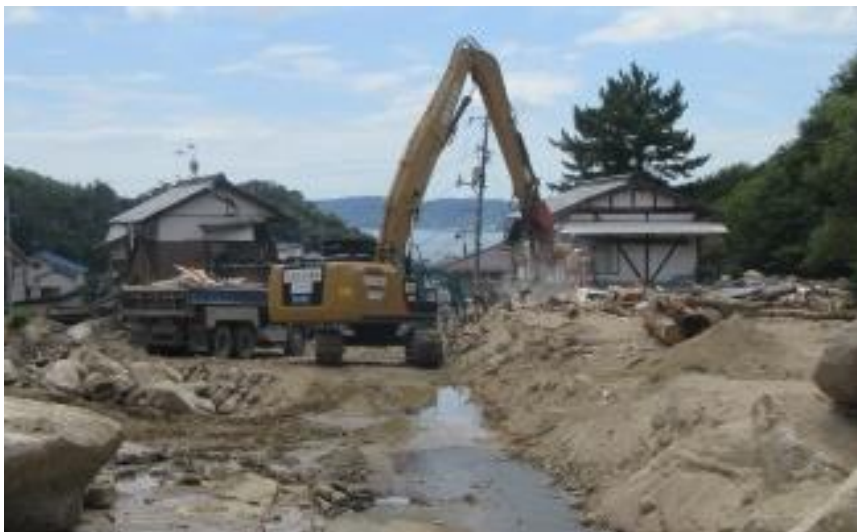
道路啓開作業（呉市天応町）
