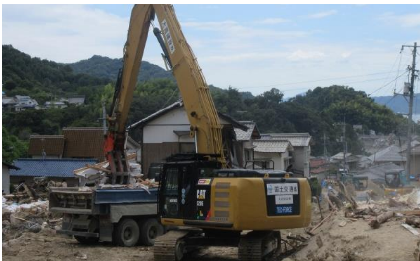
道路啓開作業（呉市天応町）
