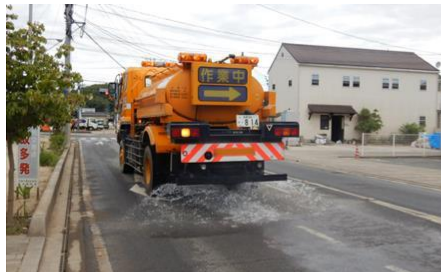
散水作業（倉敷市真備町）
