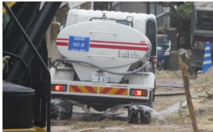
散水作業（呉市天応町）
