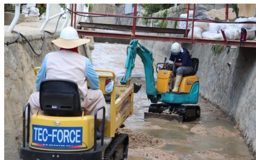
土砂撤去作業（呉市天応町）
