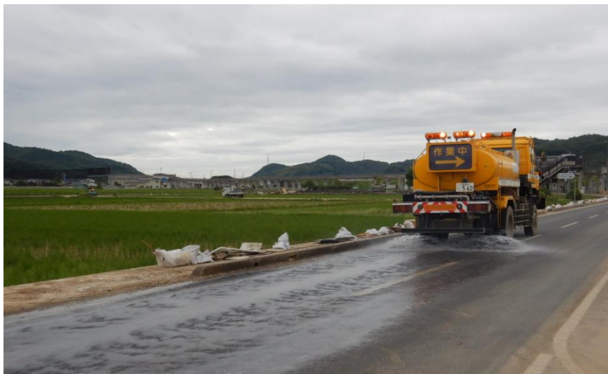
散水作業（倉敷市真備町）
