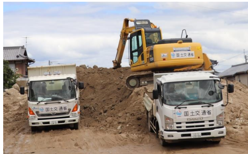
土砂撤去作業（坂町坂西）
