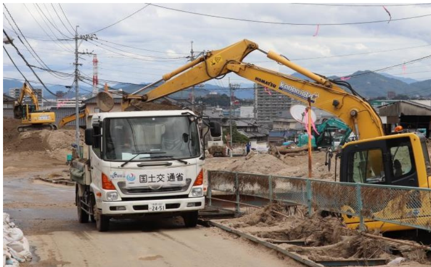
土砂撤去作業（坂町坂西）
