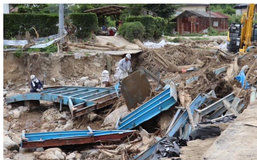
落橋切断撤去作業（坂町坂西）
