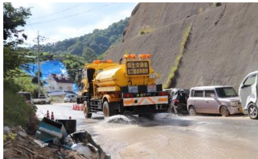
散水作業（坂町小屋浦）
