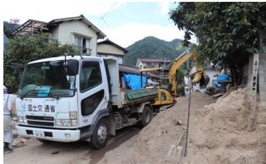
土砂撤去作業（坂町小屋浦）
