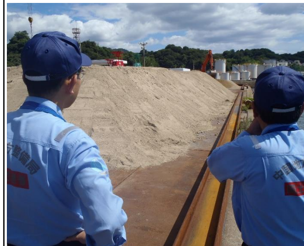
災害土砂の海上積出し拠点の確認 (坂町鯛尾)
