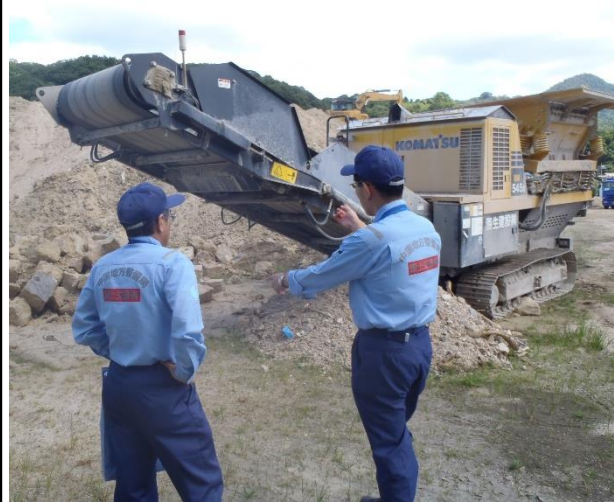
災害土砂の仮置き場の確認 (坂町北新地運動公園)
