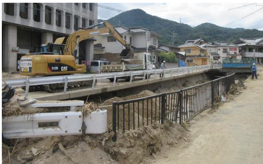
土砂撤去作業（坂町坂西）
