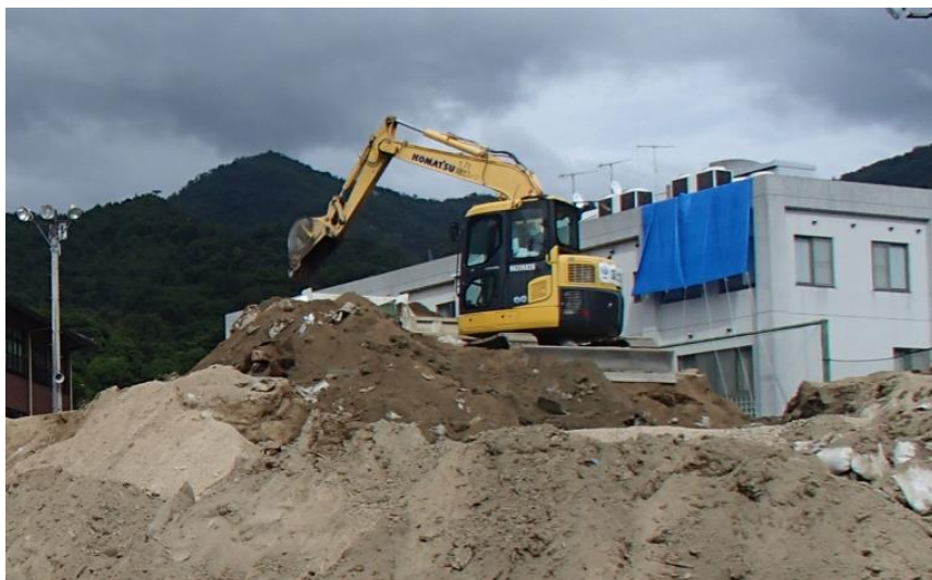
道路啓開作業（坂町小屋浦）
