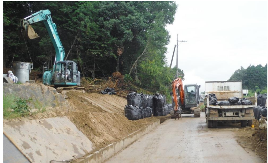
大型土のう設置作業（東広島市高屋町）
