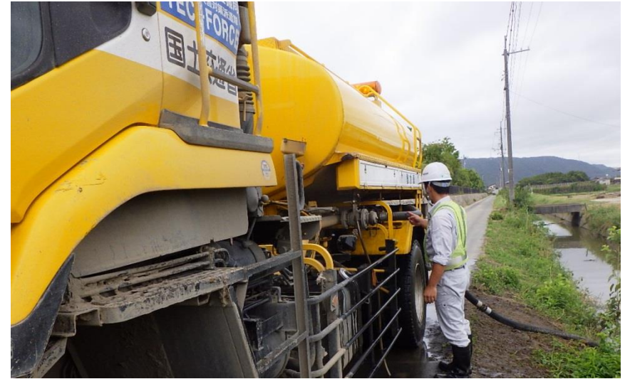
給水作業（倉敷市真備町）
