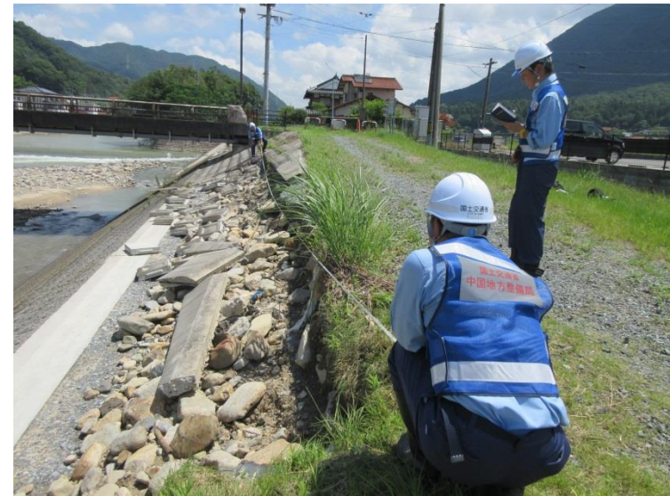
広島市(三篠川) 被災状況調査
