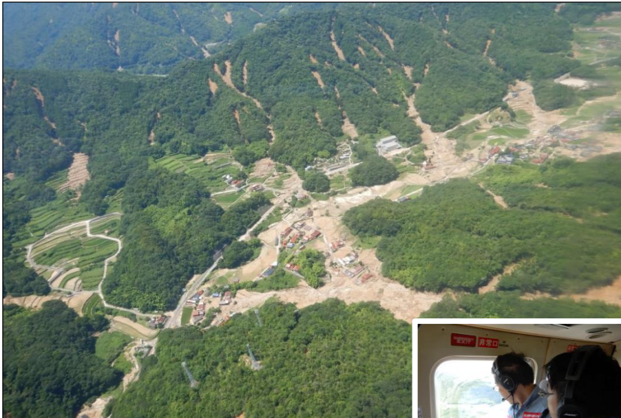
土砂災害専門家による調査状況 (広島県呉市安浦町下垣内・中畑地区)
