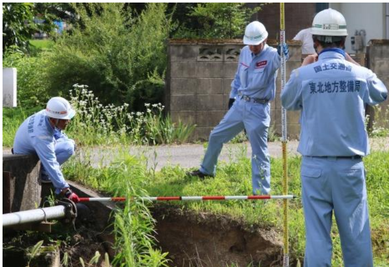
被災状況調査
