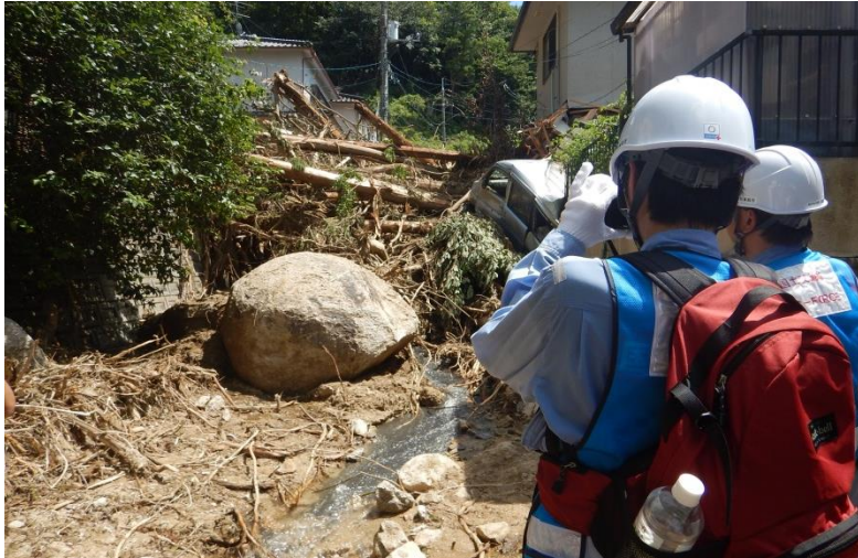
広島市(矢野川支川) 被災状況調査
