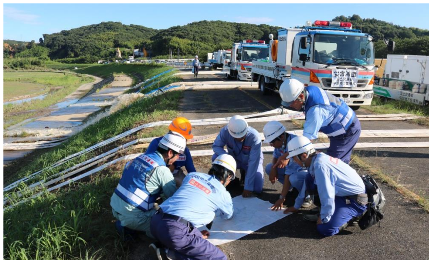
作業工程打合せ
