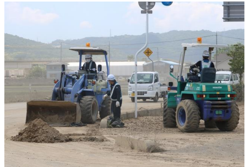
道路啓開作業
