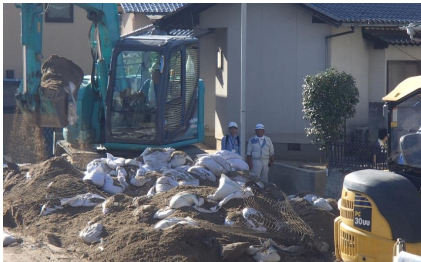
土砂撤去作業（坂町小屋浦）
