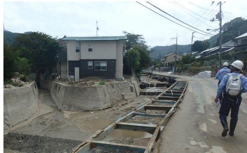
現地状況確認（坂町坂西）
