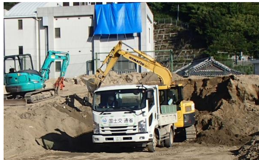
土砂撤去作業（坂町小屋浦）
