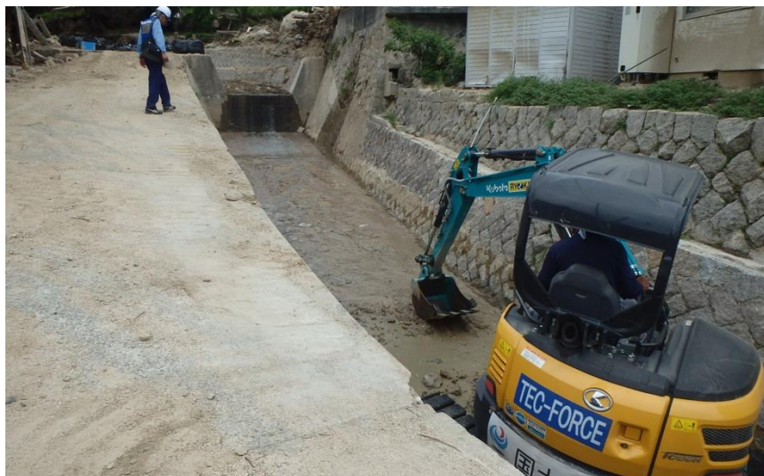
現地状況確認（呉市天応町）
