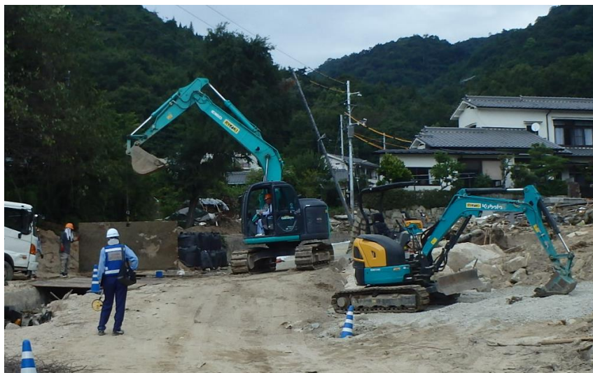
現地状況確認（呉市天応町）
