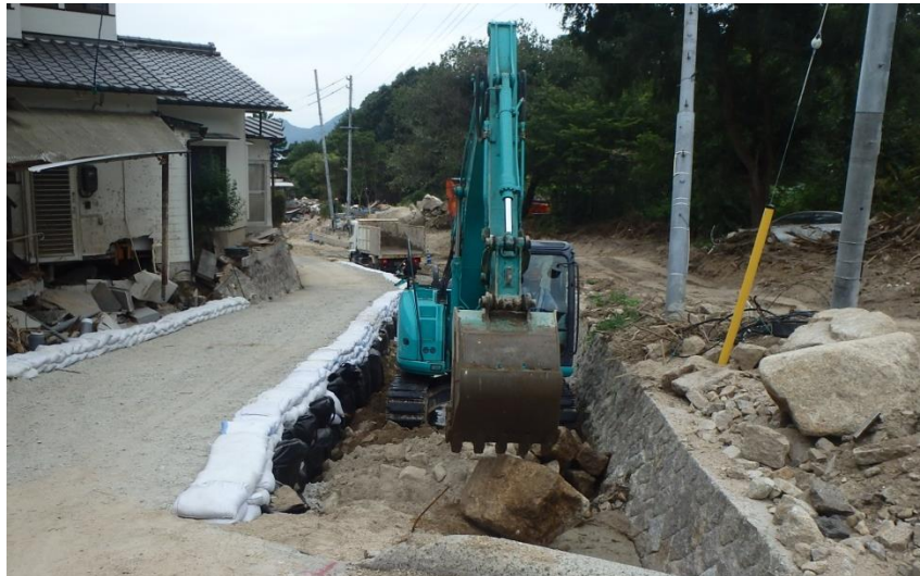
現地状況確認（呉市天応町）
