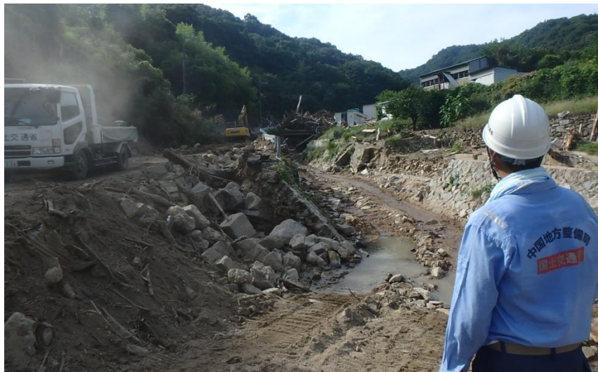
現地状況確認（坂町坂西）
