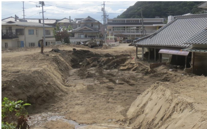
現地状況確認（坂町小屋浦）
