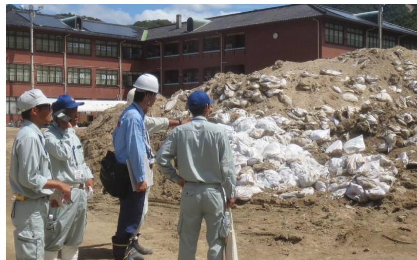
現地打合せ状況確認（坂町小屋浦）
