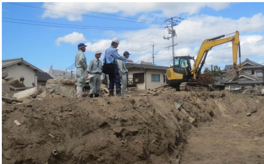
現地打合せ状況確認（坂町小屋浦）
