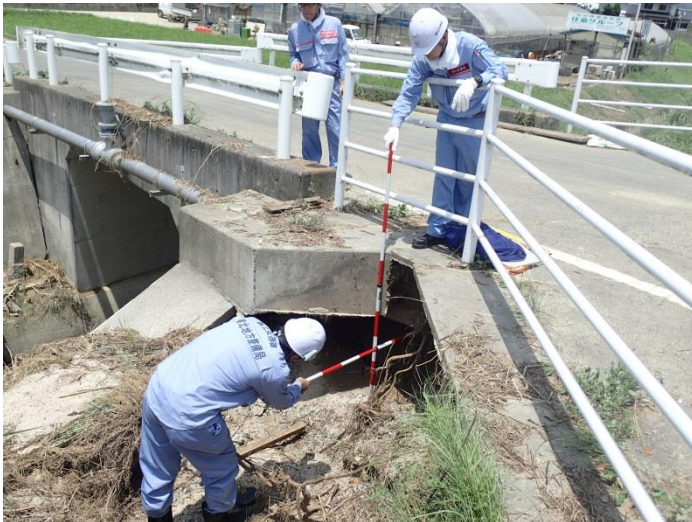
被災状況調査(倉敷市)
