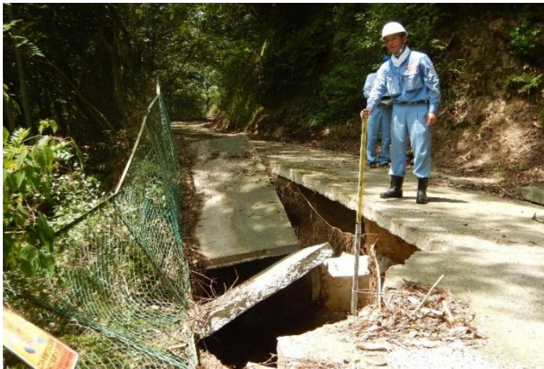
被災状況調査(赤磐市)
