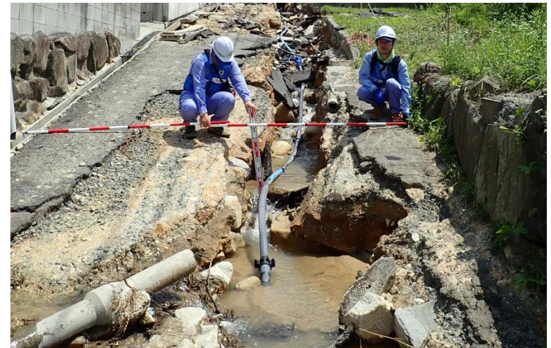
被災状況調査(東広島市)
