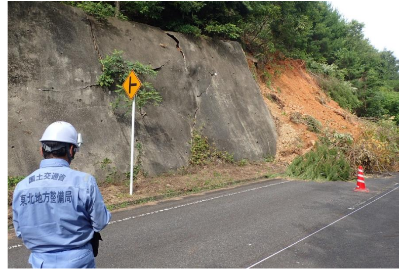
被災状況調査(総社市)
