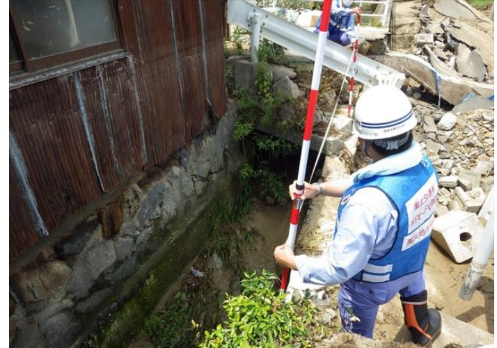
被災状況調査(東広島市)
