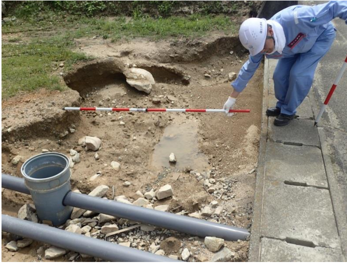
被災状況調査(倉敷市)
