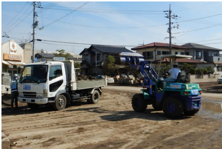
土砂撤去作業
