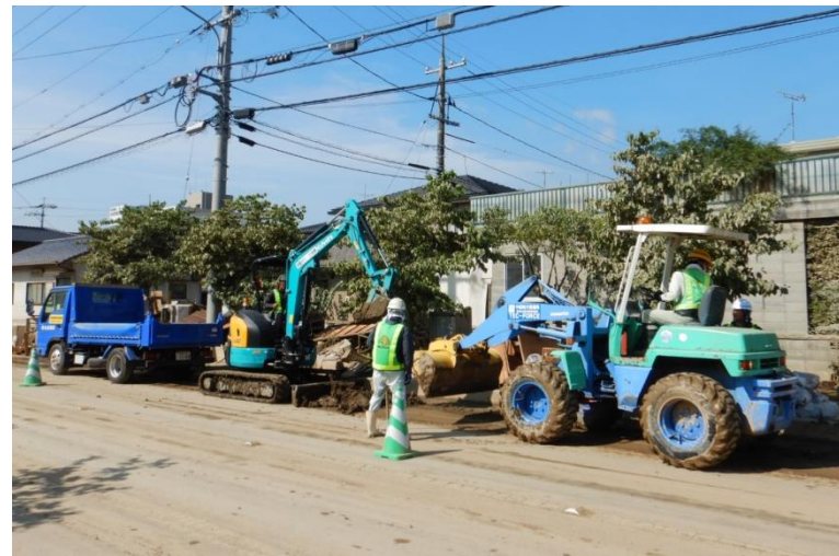
土砂撤去作業
