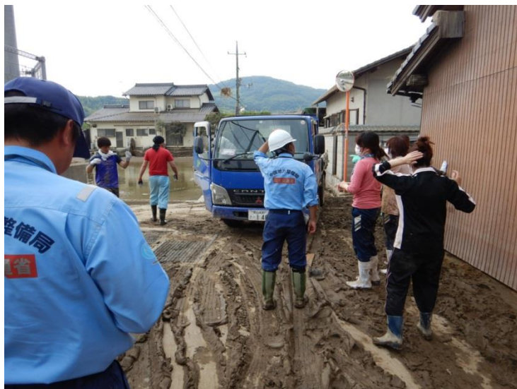
土砂撤去作業
