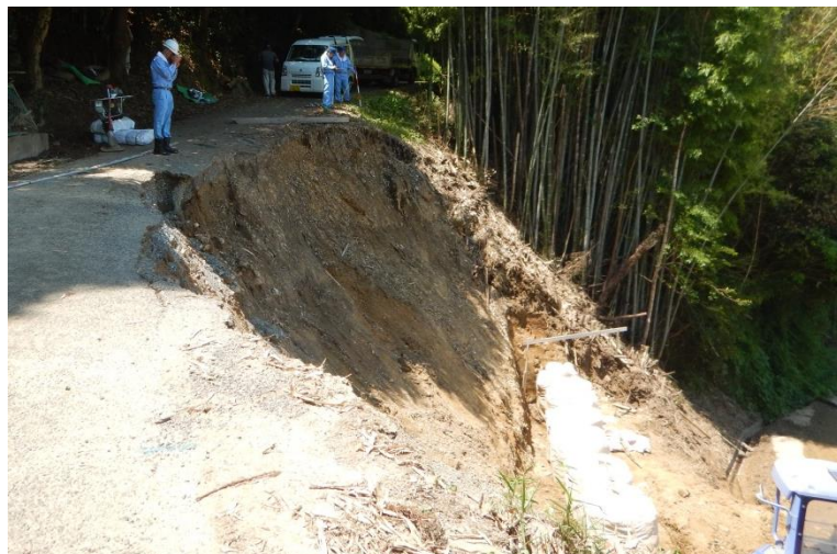
被災状況調査(倉敷市)
