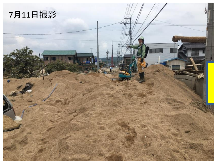
道路啓開作業 着手前
