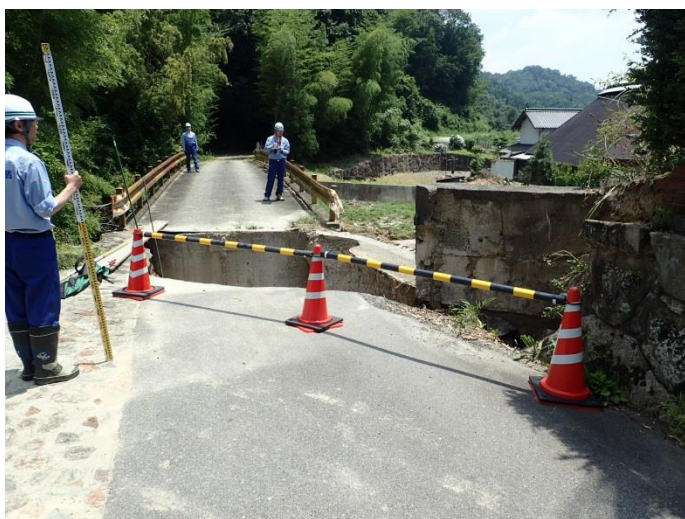
被災状況調査(三原市)
