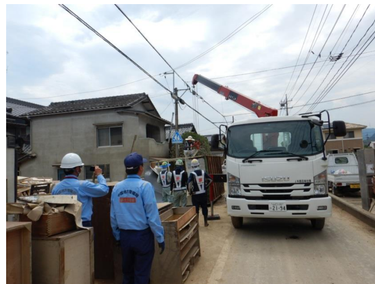
支障物撤去作業
