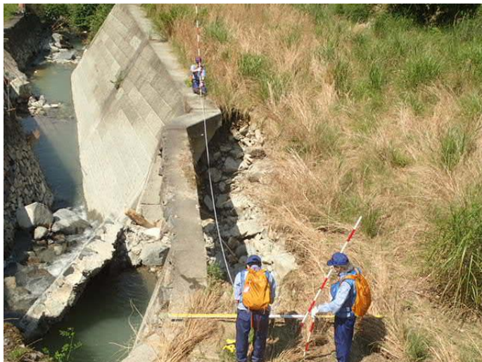
被災状況調査(三原市)
