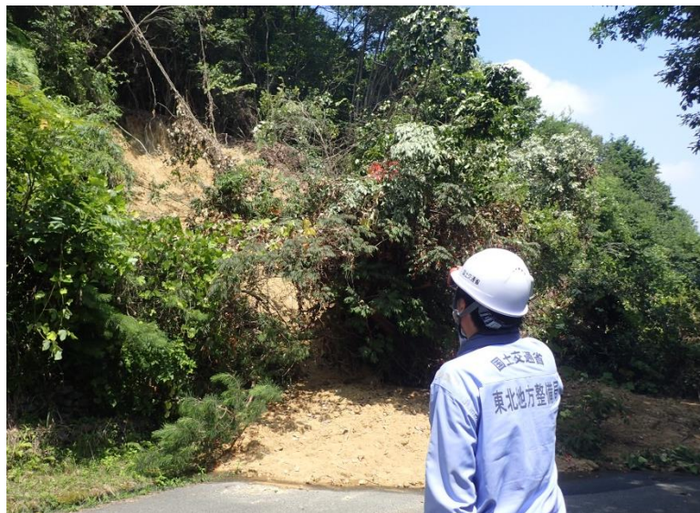
被災状況調査(倉敷市)
