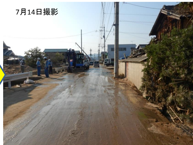
道路啓開作業 完了
