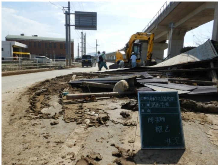
道路啓開作業中
