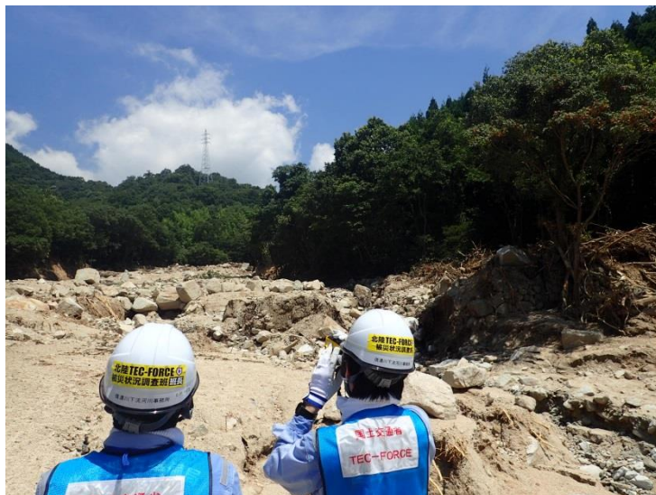
被災状況調査(呉市)
