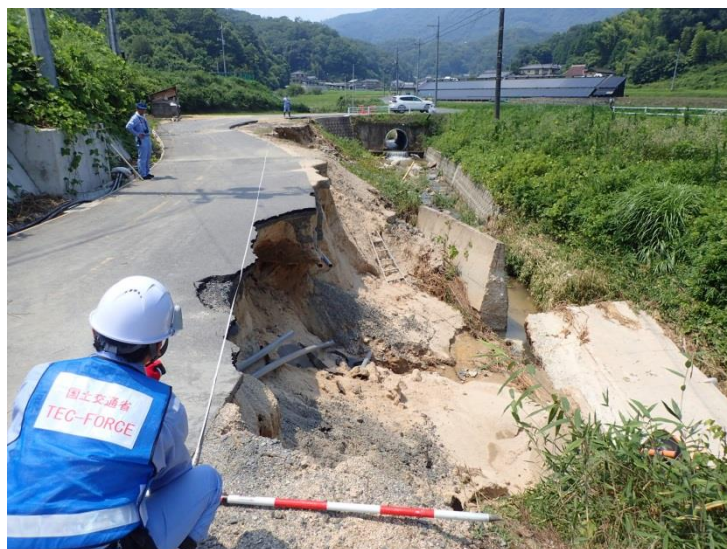
被災状況調査(総社市)
