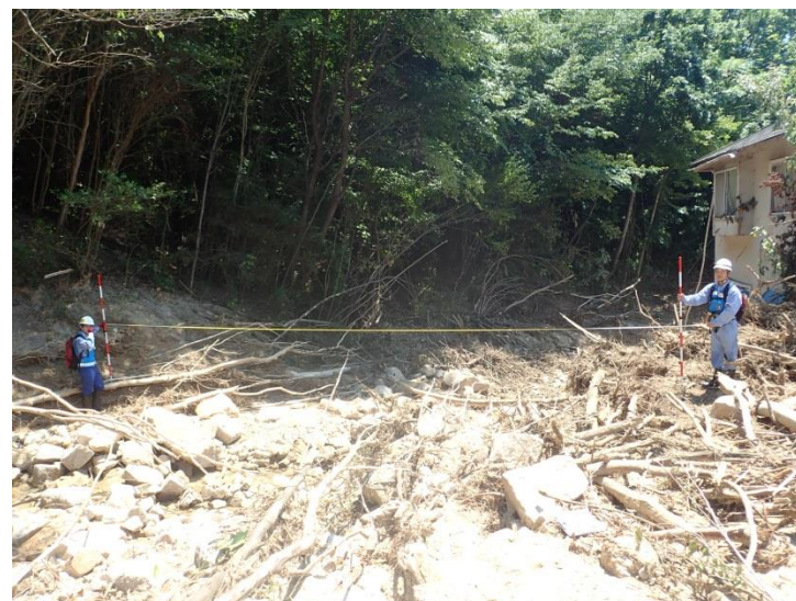
被災状況調査(呉市)
