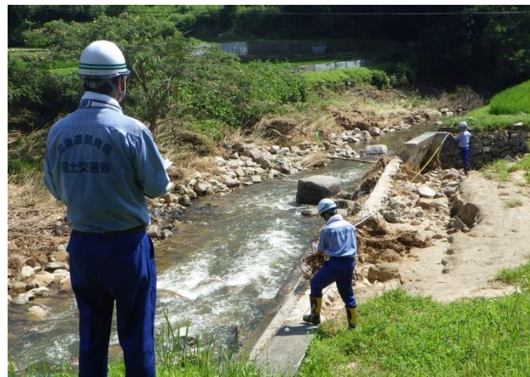
被災状況調査(三原市)
