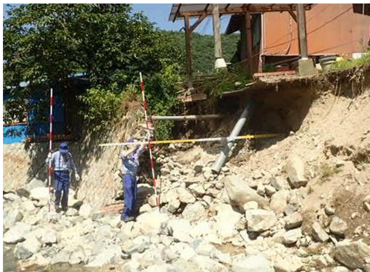
被災状況調査(東広島市)
