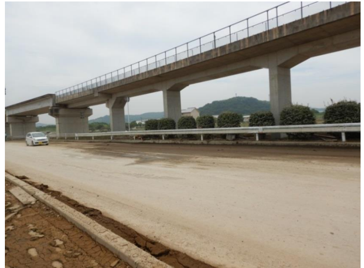
道路啓開作業 完了
