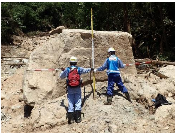
被災状況調査(呉市)
