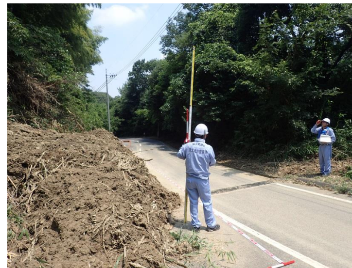
被災状況調査(倉敷市)
