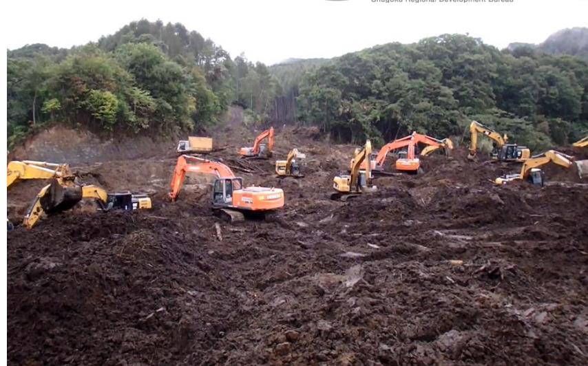
土砂撤去作業（厚真町）
