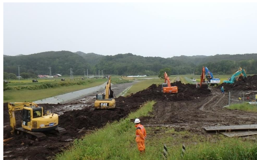
土砂撤去作業（厚真町 9月10日）
