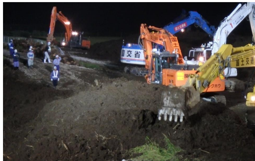
土砂撤去作業（厚真町）
