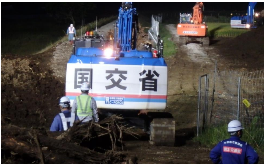
土砂撤去作業（厚真町）
