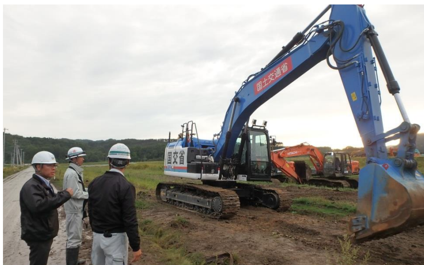
バックホウの遠隔操縦装置動作確認（厚真町 9月10日）
