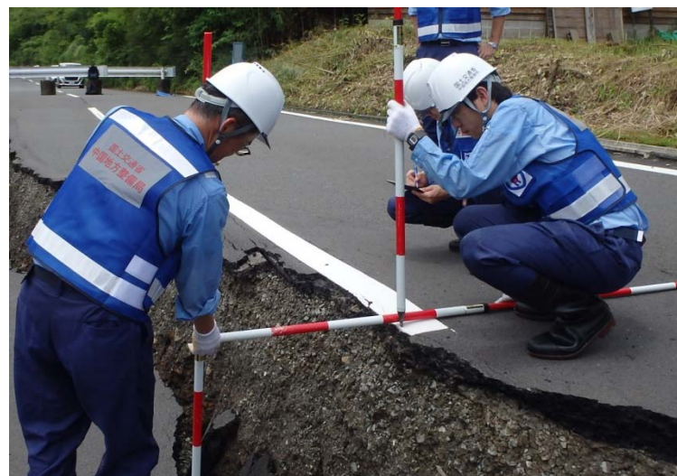
現地調査状況
