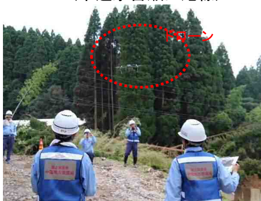
砂防ドローン班 被災状況調査② （鹿屋市輝北町上百引地内）
