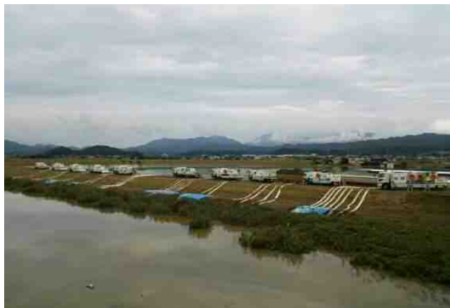
排水ポンプ車による排水作業(佐賀県武雄市)
