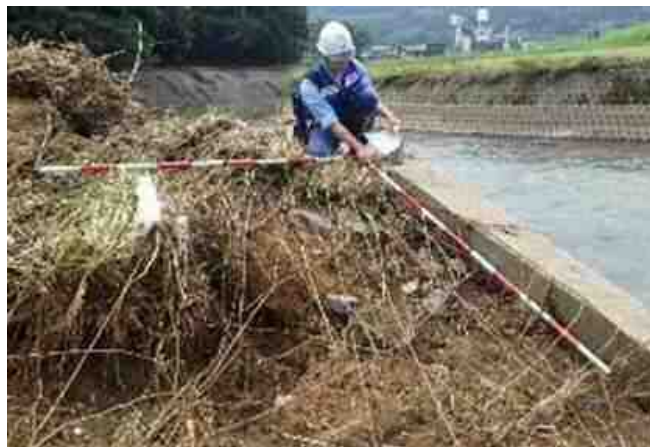
河川被災状況調査(六角川水系牛津川)
