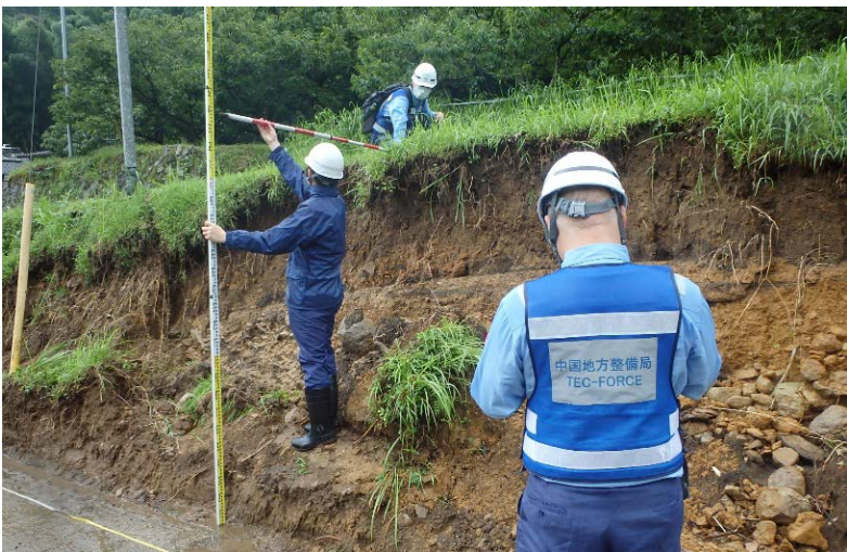
道路班による現地調査（熊本県人吉市内）
