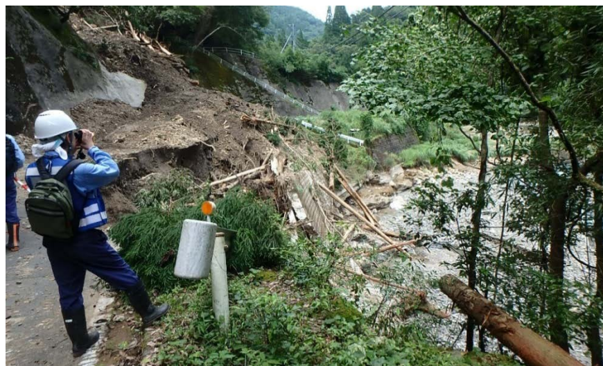
河川班による現地調査（熊本県球磨村）
