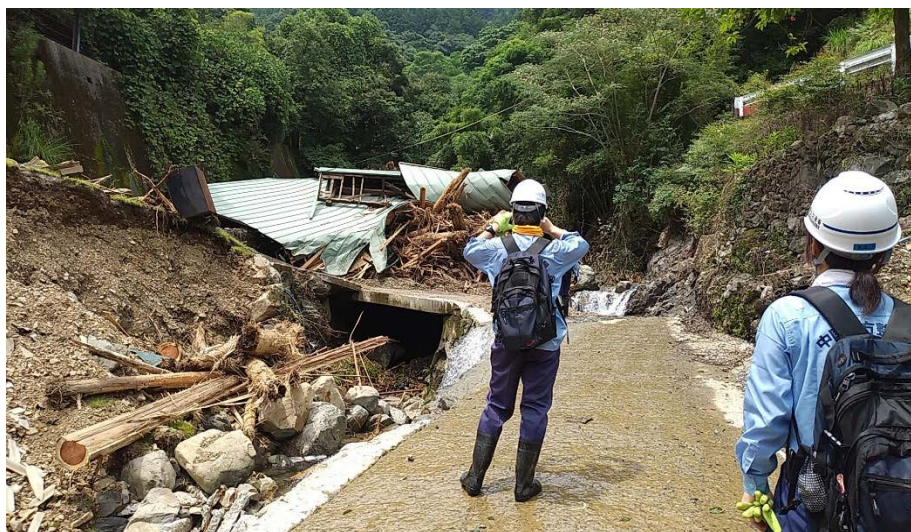
砂防班による現地調査（熊本県球磨村）
