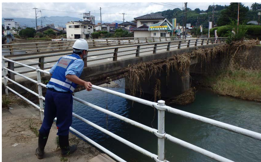
道路班による現地調査(橋梁の点検)（熊本県人吉市）
