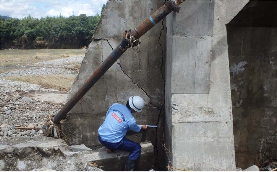
球磨川に架かる天狗橋(人吉市)現地調査(道路班)
