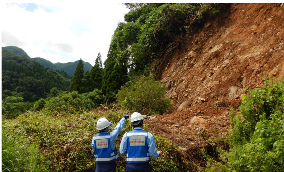
道路班による現地調査（熊本県球磨村）
