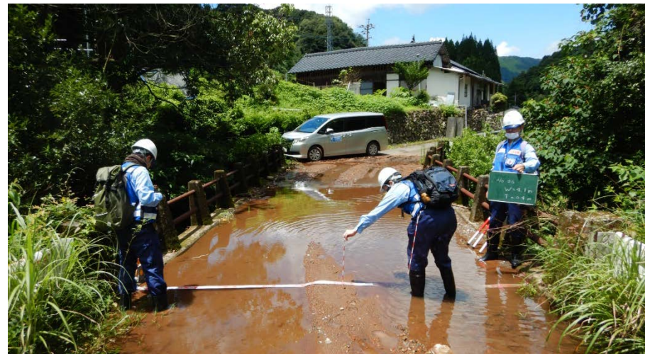
道路班による現地調査（熊本県球磨村）
