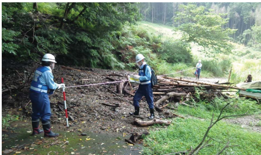
道路班による被災状況調査（人吉市）
