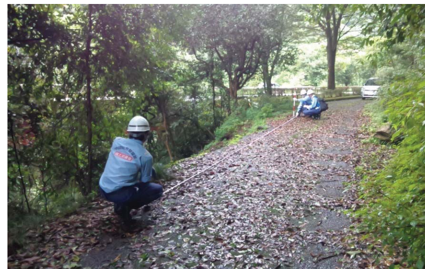
道路班による被災状況調査（人吉市）
