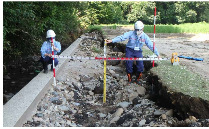
河川班による被災状況調査（人吉市）
