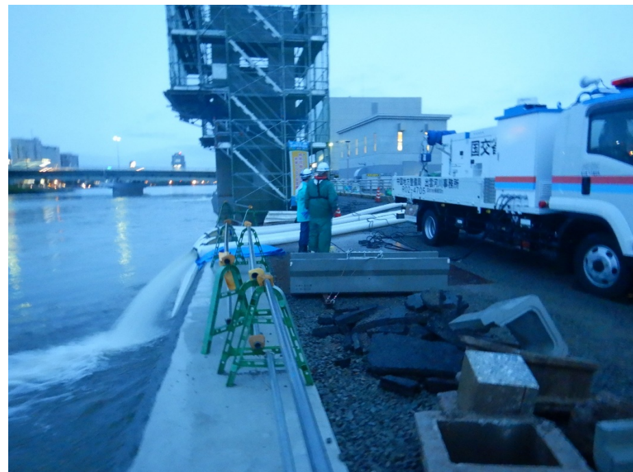
上追子川における排水状況（松江市）
