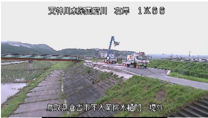
不入岡排水樋門
