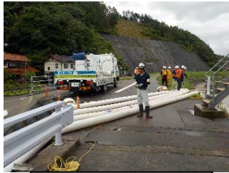
南田川排水樋門
