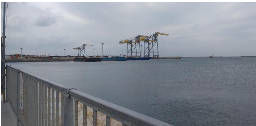
新港ふ頭地区の状況
