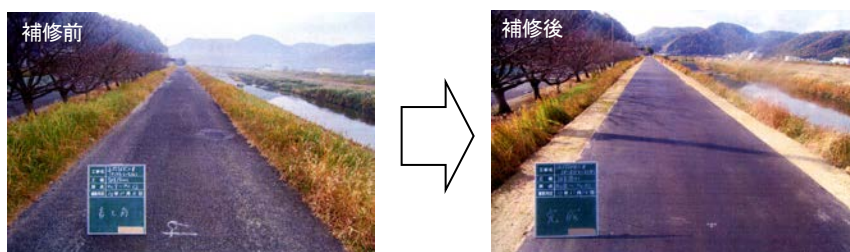
写真 5-2-9 堤防天端（上面）の補修状況
