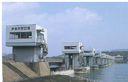
写真 1-2-3 芦田川河口堰（昭和 56 年 6 月完成）
