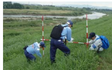
写真 5-2-2 堤防の点検状況
