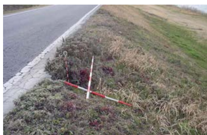
写真 2-3-1 堤防の陥没
