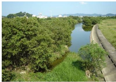
写真 2-3-3 河道内樹木の繁茂
