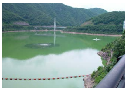
写真 2-2-36 アオコの発生状況（八田原ダム）
