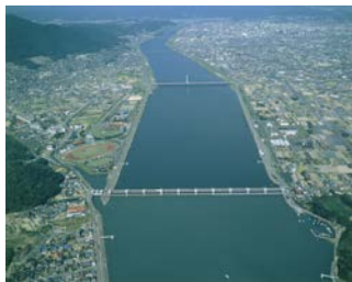
写真 2-2-25 芦田川河口堰と湛水区間
