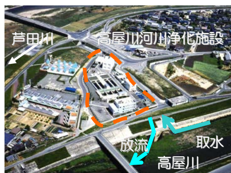
写真 5-1-9 高屋川河川浄化施設
