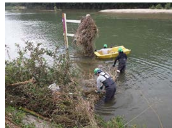
写真 5-2-15 塵芥除去作業状況
