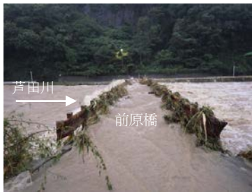
写真 2-1-1 平成 30 年 7 月豪雨の状況
