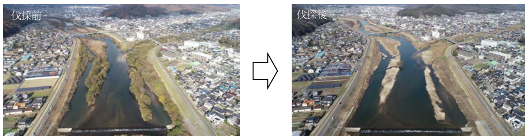
写真 5-2-13 河道内樹木の伐採状況 (22k 付近)
