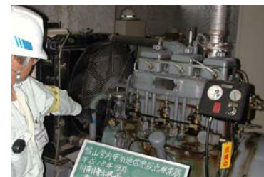
写真 5-2-3 排水機場の点検状況
