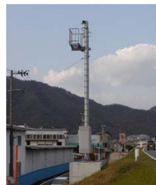
写真 5-2-11 CCTV の設置状況
