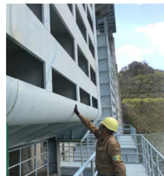
写真 2-3-5 ゲート扉体の点検状況
