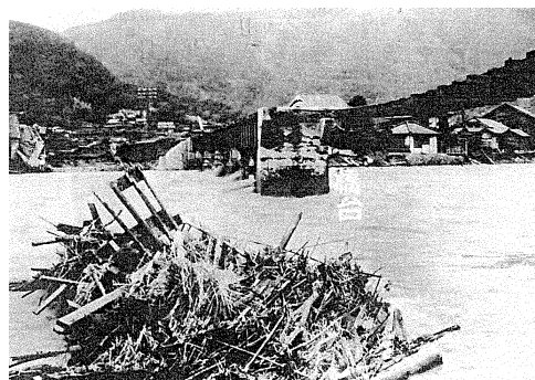
府中市父石町の浸水状況
