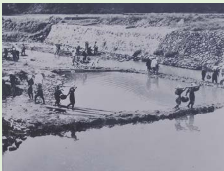
復旧状況写真：終戦間もない頃で男手が少なく女性達の労働力が頼りであった （府中市歴史民族資料館提供写真）
