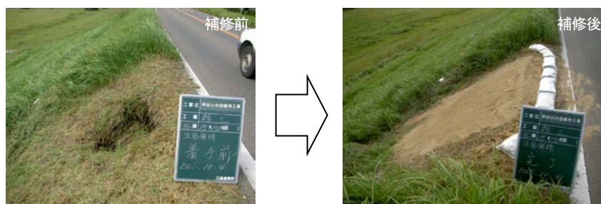
写真 5-2-8 堤防の補修状況
