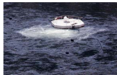
写真 5-1-12 躍層低下循環装置
