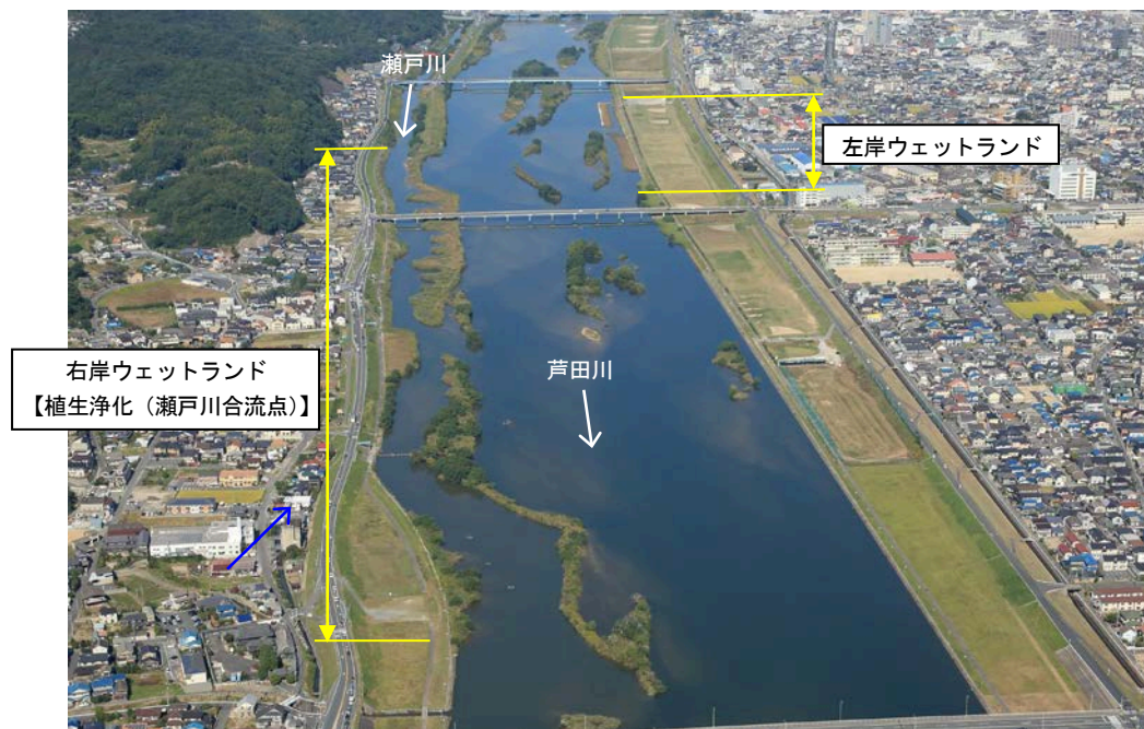
写真 5-1-10 植生浄化の整備状況
