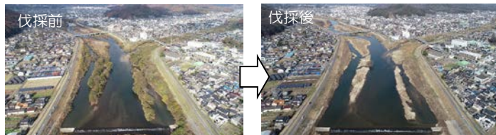
河道内樹木の伐採状況（22k付近）
