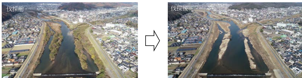
写真 5-2-13 河道内樹木の伐採状況 (22k 付近)
