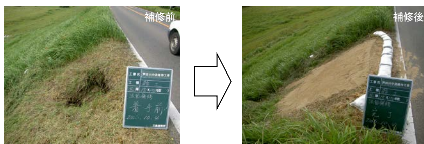
写真 5-2-8 堤防の補修状況
