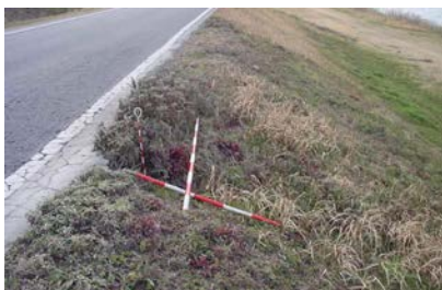
写真 2-3-1 堤防の陥没
