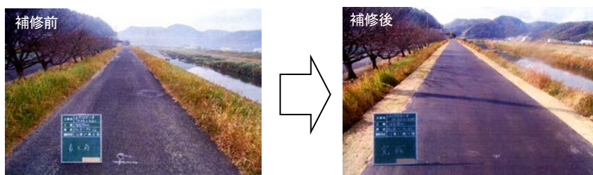
写真 5-2-9 堤防天端（上面）の補修状況
