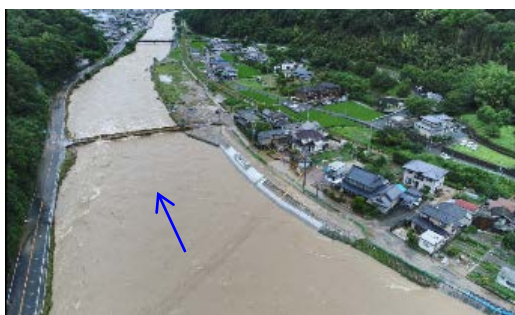
府中市父石町付近の浸水状況
