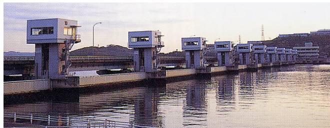
写真 2-2-26 芦田川河口堰と河口大橋
