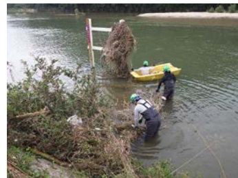
写真 5-2-15 塵芥除去作業状況
