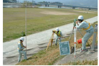
写真 5-2-4 縦横断面測量
