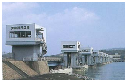
写真 1-2-3 芦田川河口堰（昭和 56 年 6 月完成）
