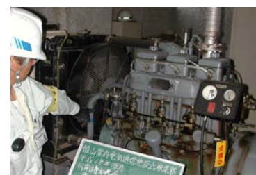
写真 5-2-3 排水機場の点検状況
