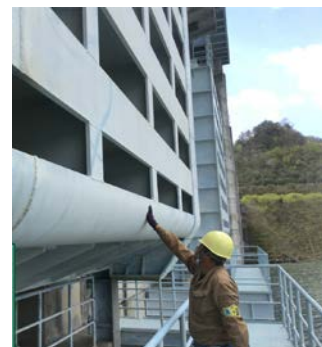
写真 2-3-5 ゲート扉体の点検状況
