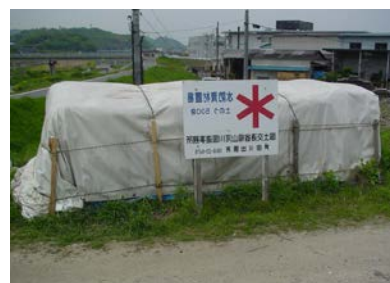
写真 5-2-34 緊急用資機材（土のう）の備蓄状況
