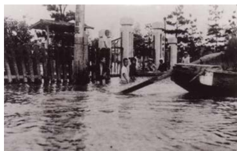
南小学校前の浸水状況
