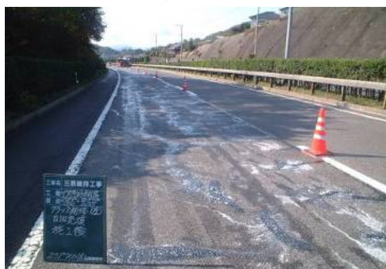
ひび割れ補修材注入
