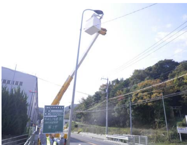
道路照明灯のランプ球替え
