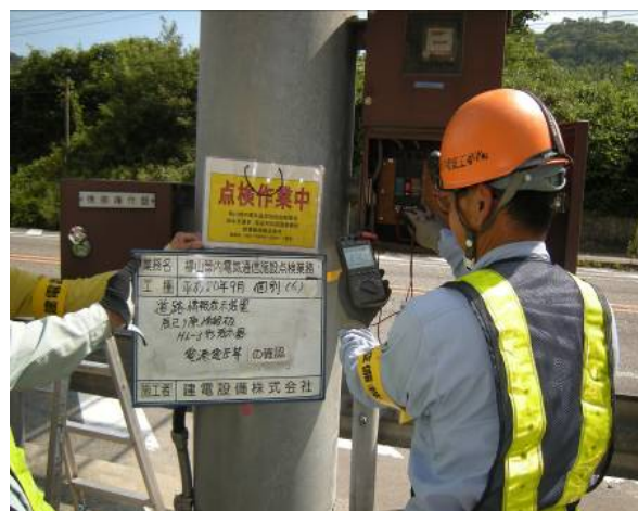
道路情報板の点検状況
