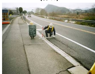
小構造物等の補修 (縁石)
