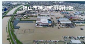
平成30年7月豪雨での被害状況
