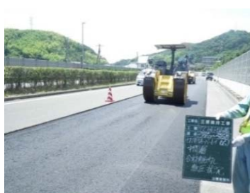
舗裝修繕 (切削オーバーレイ工)
