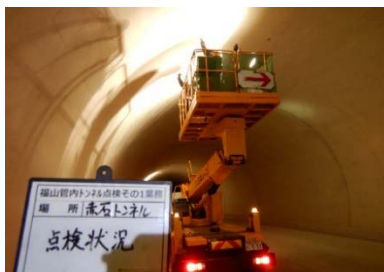
トンネル点検
