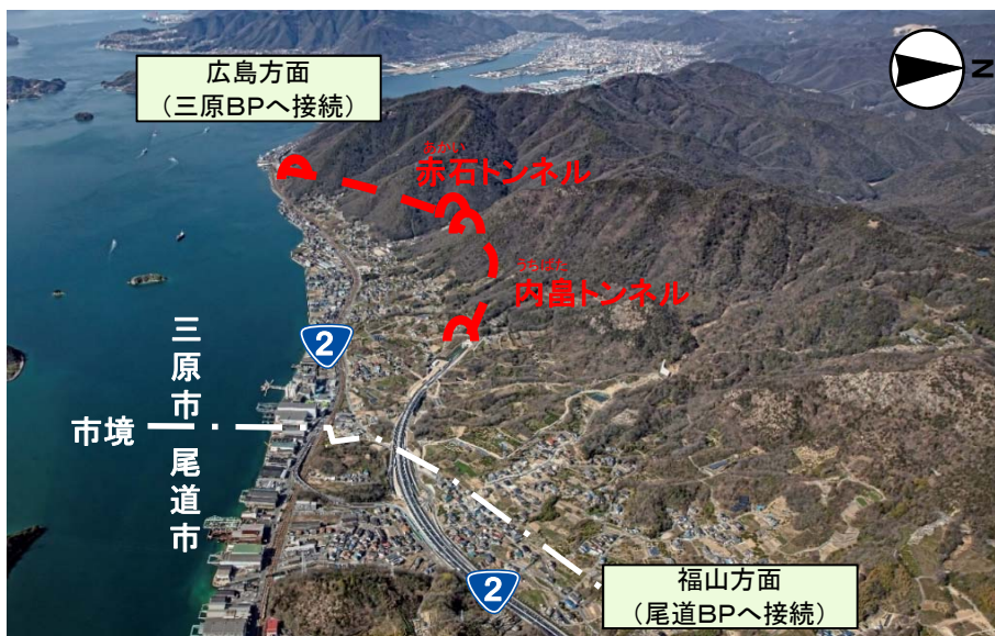
一般国道2号木原道路 R3年7月撮影 尾道バイパス終点部から三原バイパス方面を望む
