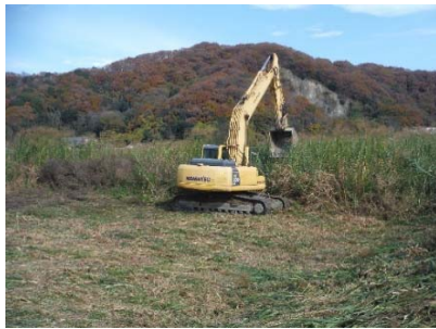
重機による幼木の踏み倒し (再繁茂抑制対策)
