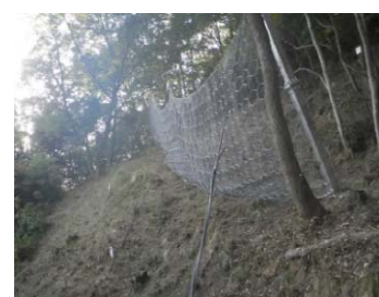
防災工事 (落石防止柵工)
