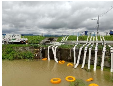
排水ポンプ車稼動状況
