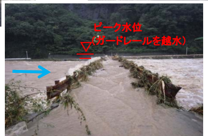
H30.7洪水 前原橋橋面部越水
