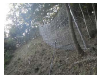
防災工事 (落石防止柵工)
