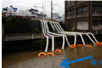
排水ポンプ車稼動状況
