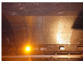
トンネル補修 (頂版部の剥落防止ネット設置)
