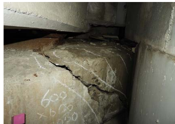
【損傷状況:断面欠損】
