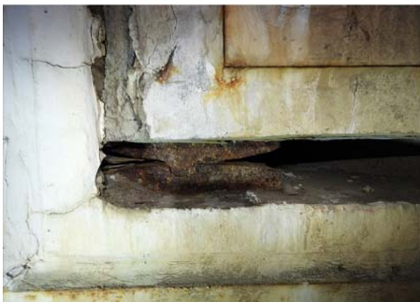
【損傷状況:支承の腐食】
