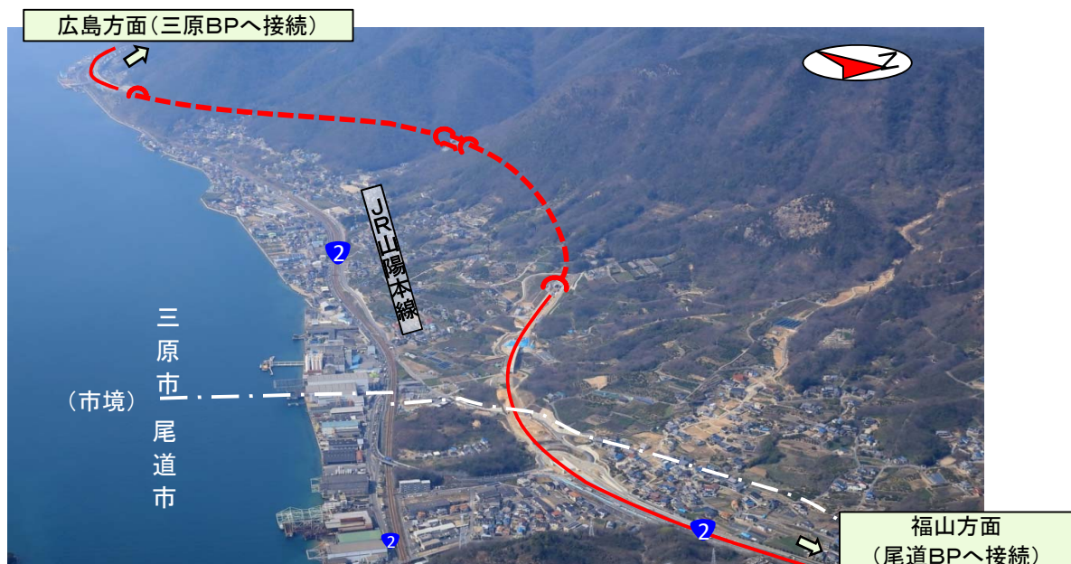
一般国道2号木原道路 H31年3月撮影 尾道バイパス終点部から三原バイパス方面を望む
