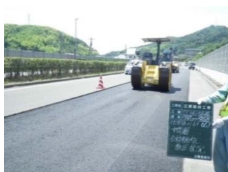
舗装修繕 (切削オーバーレイ工)
