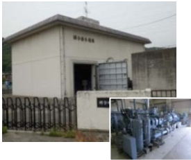
排水機場の長寿命化対策 (郷分排水機場)
