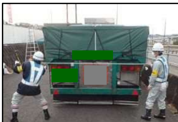
車両幅計測状況（R2.12）下り
